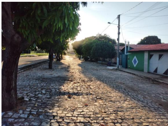
Figura 3 - Acesso rua projetada do terreno
