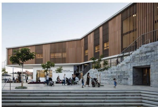
Figura 47 - Centro Comunitário Rehovot
