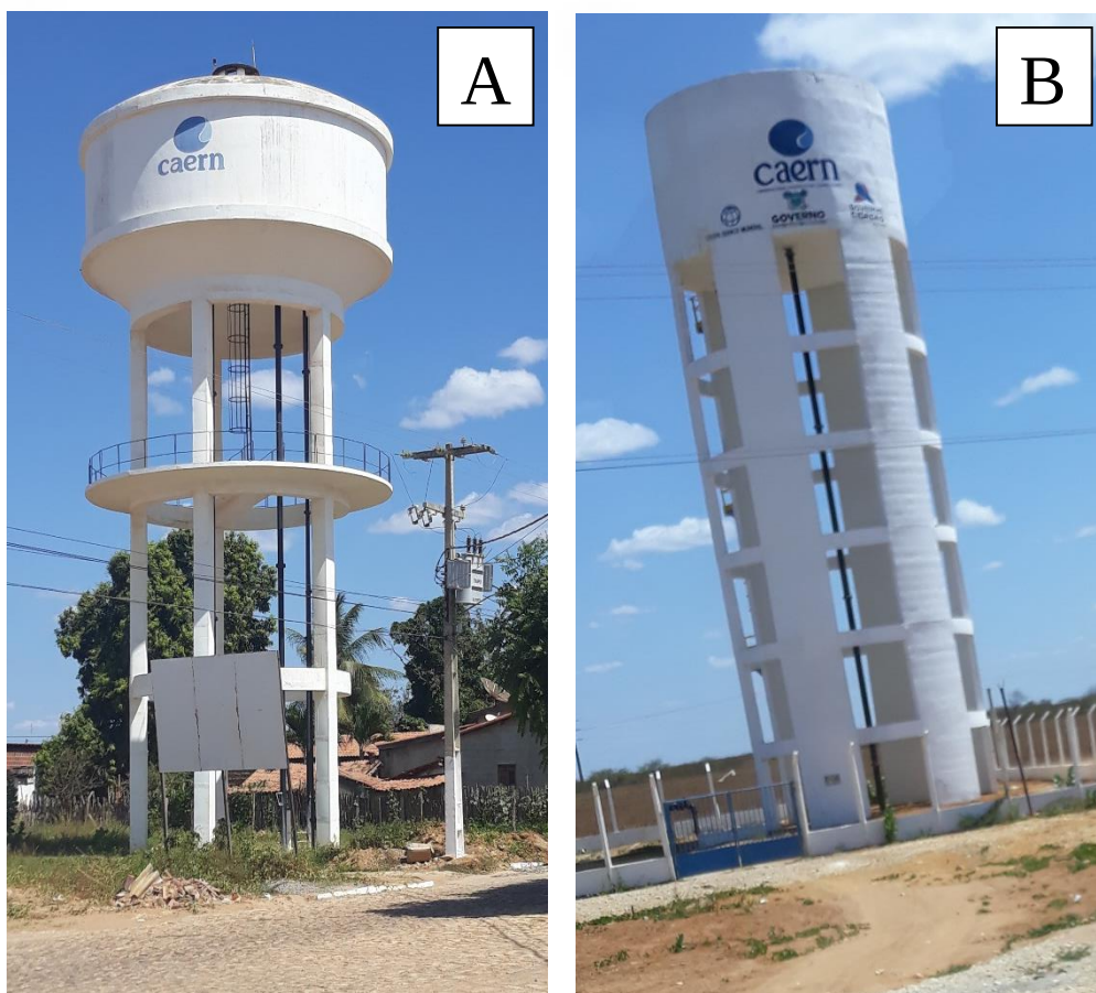
Figura 3 – Reservatórios elevados da cidade de Baraúna/RN (A) e comunidade Juremal (B).
