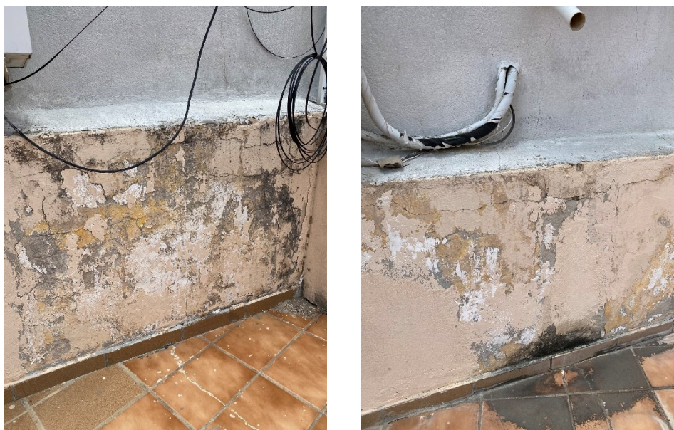
Figura 7 - Trincas e fissuras encontradas no pavimento superior da edificação
