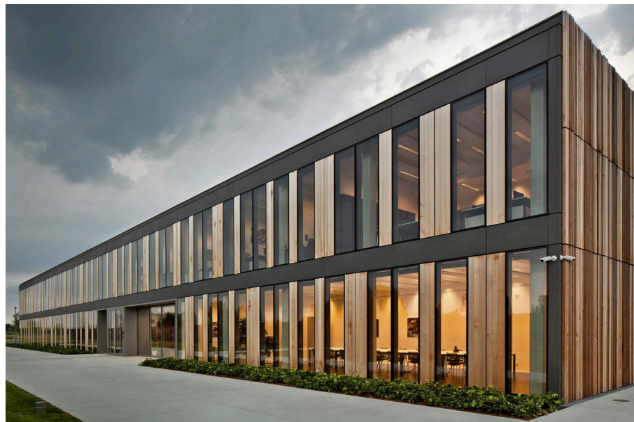
Figura 13: Fachada Fábrica Berluti.
