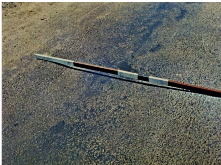
Figura 6 - Afundamento local
