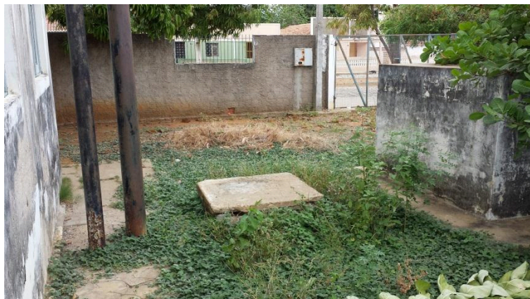
Figura 12 - Estado do terreno onde está localizado o reservatório de água
