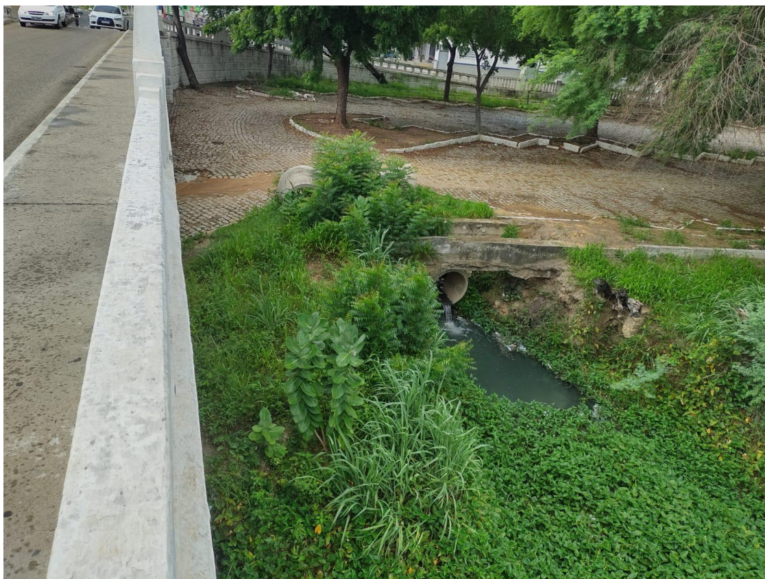
Figura 3: Ponto de descarga de esgoto localizado na ponte do centro da cidade de Mossoró.
