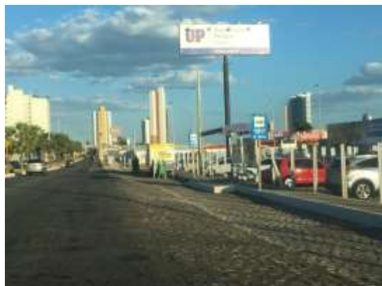
Foto 3: Avenida João da Escóssia
