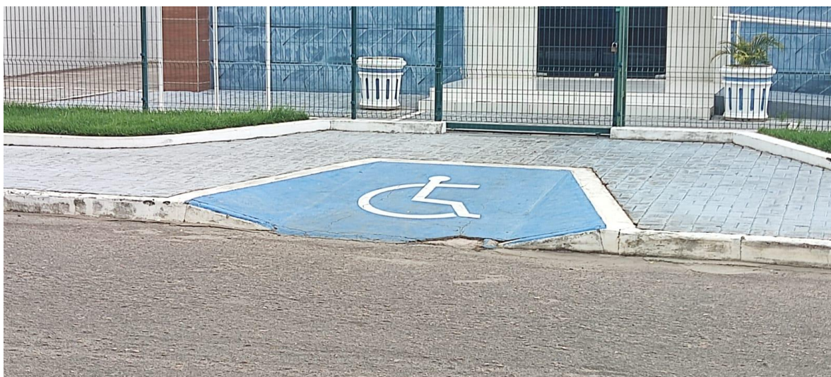
Figura 23 – Calçadas em estado bom e acessível.
