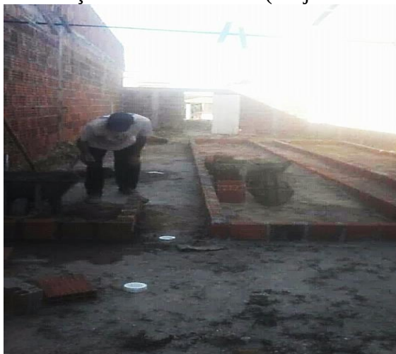
Figura 15 - Construção dos canteiros no (Projeto Realizando Sonho)
