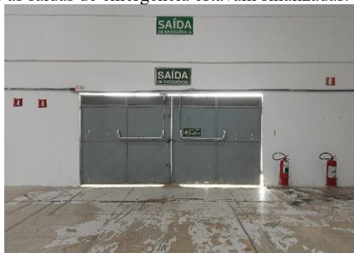
Figura 14. Saída de emergência no local da feira de ciências (Autoria própria, 2025).
