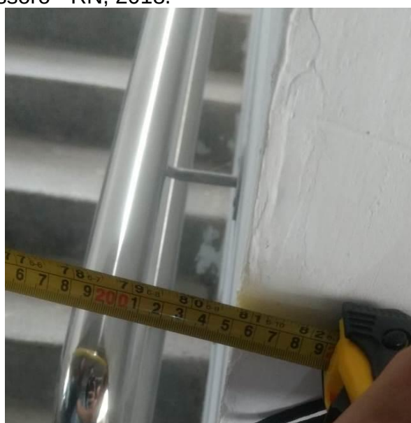
Figura 8 - Largura da escada central instalada em uma obra de construção civil na cidade de Mossoró - RN, 2018.
