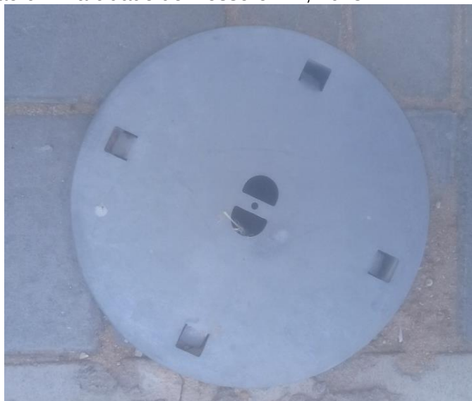
Figura 14 - Caixa de inspeção destinada ao aterramento do sistema de SPDA em uma obra de construção civil na cidade de Mossoró-RN, 2018.
