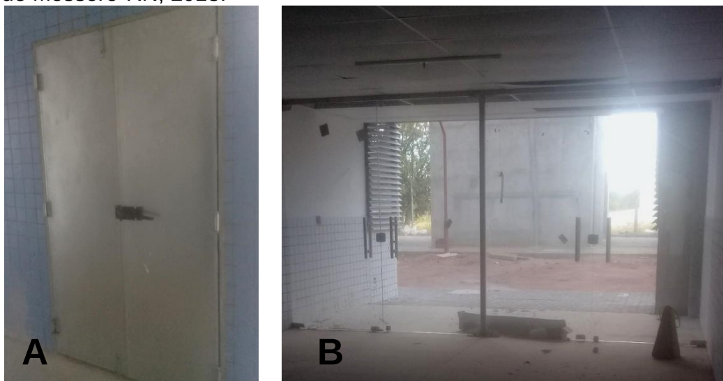
A: Porta corta fogo de duas folhas; B: Portas de vidro de duas folhas; Fonte: Arquivo pessoal (2018).
