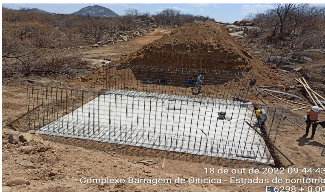
Figura 04: Construção de um Bueiro Duplo Celular de Concreto de 2,00 m de altura por 2,00 m de largura (BDCC 2,00 x 2,00m).
