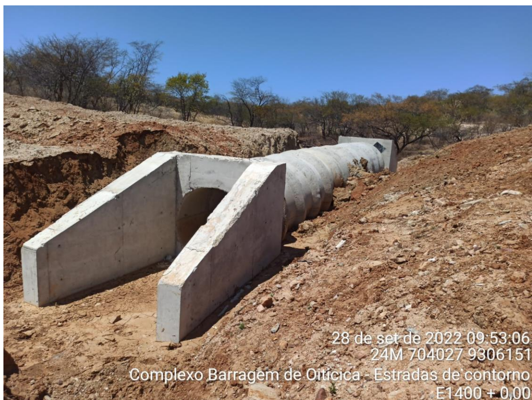
Figura 03: Implantação de um Bueiro Simples Tubular de Concreto de 1,50 m de diâmetro (BSTC Ø 1,50).
