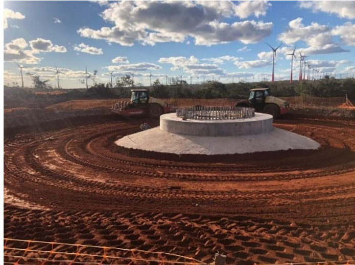
Figura 3: Exemplo de fundação direta
