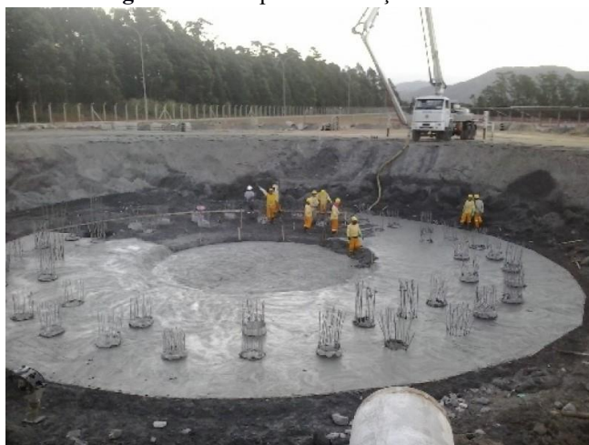
Figura 4: Exemplo de fundação indireta
