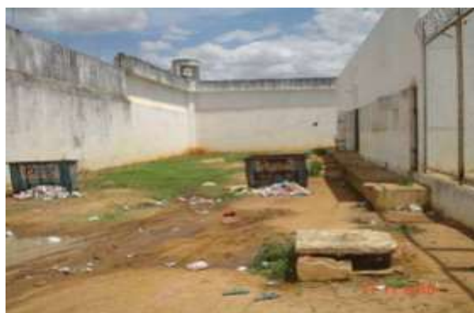
Imagem 02 – Área externa do pavilhão destinado ao regime fechado com lixo e esgoto ao céu aberto
