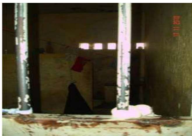
Imagem 04 – Interior da cela
