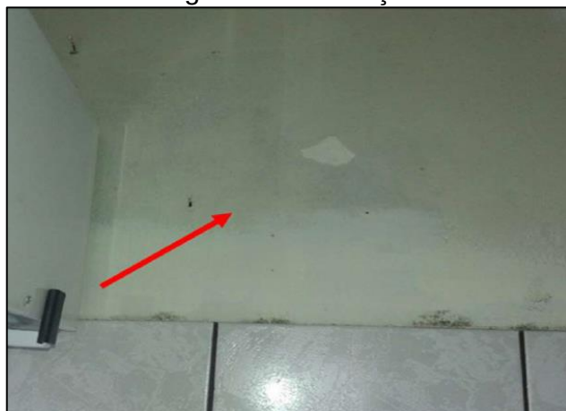
Figura 5 – Infiltração
