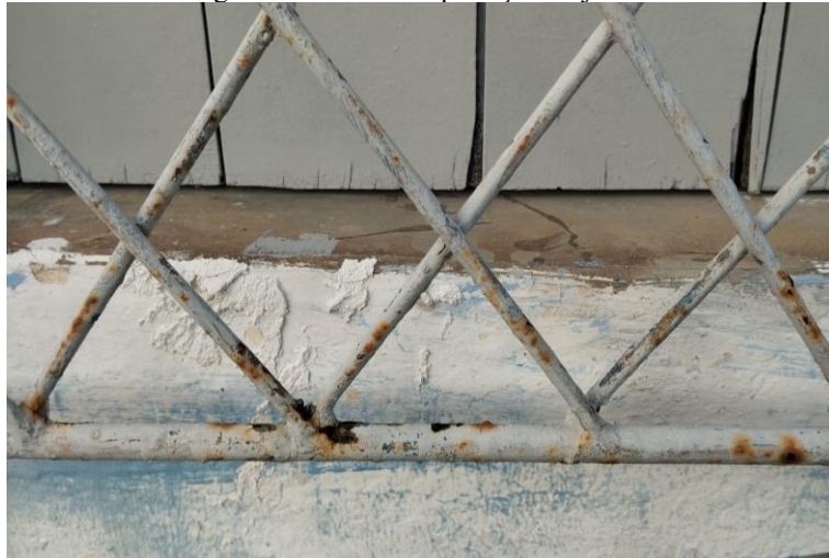
Figura 19 - Grade de proteção na janela
