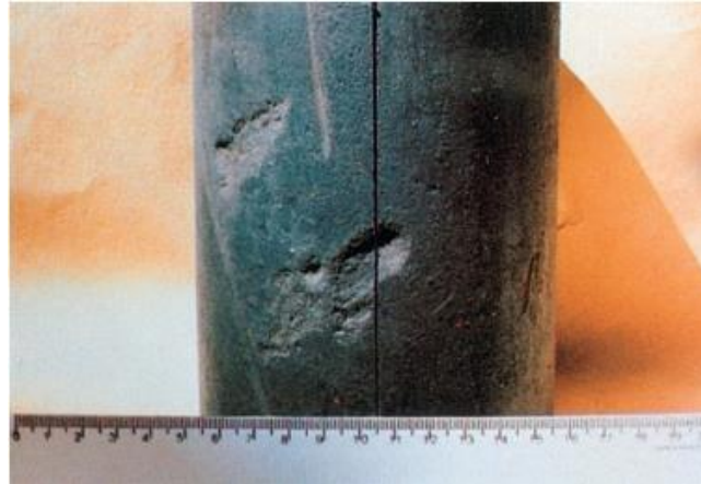
Figura 3 - Corrosão eletrolítica em aço-carbono ocasionadas por correntes de fuga
