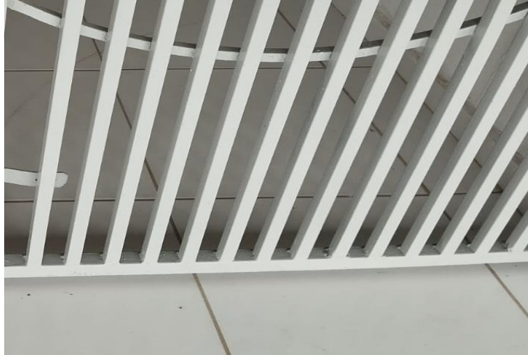
Figura 24 - Portão de entrada após revestimento
