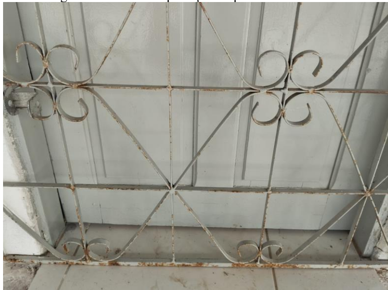
Figura 20 - Grade de proteção na porta de sala de aula
