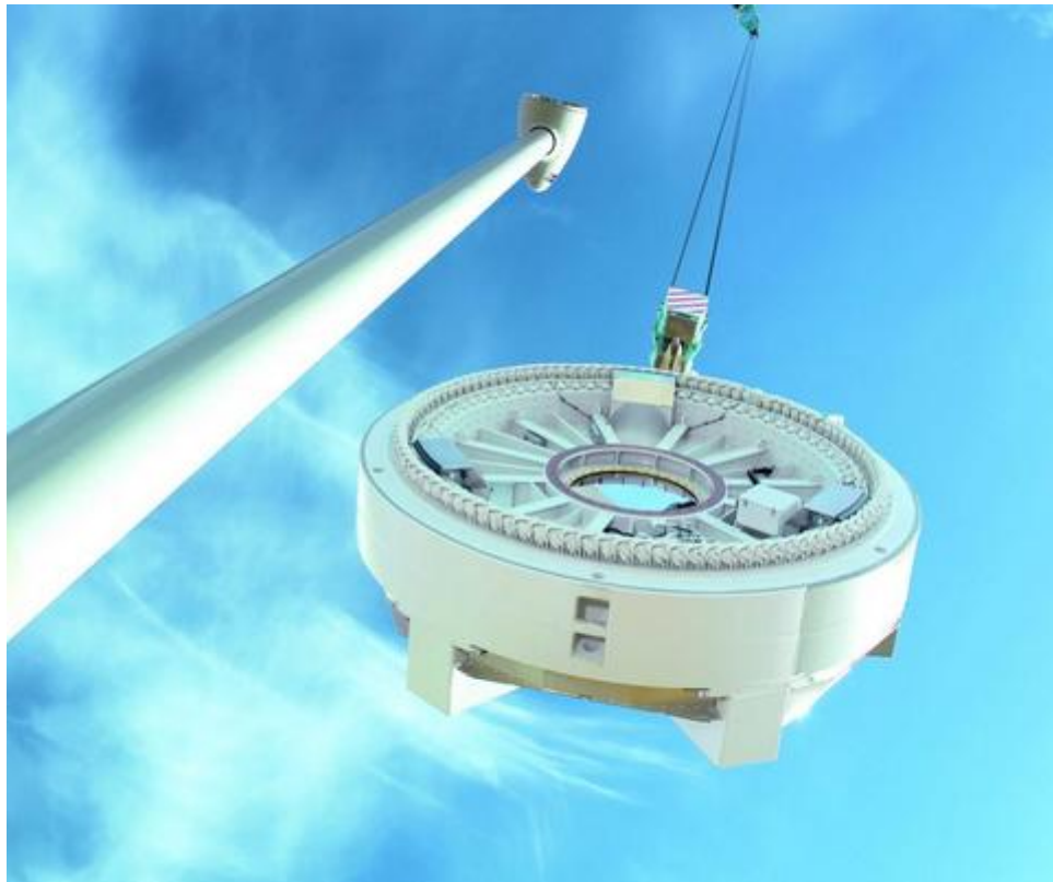
Figura 8 -Rotor do Gerador Síncrono para Aplicação em Sistemas Eólicos
