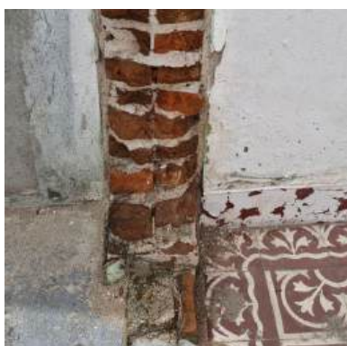
Figura 12 — Tijolos de Adobe em residência do centro de Souza - PB.
