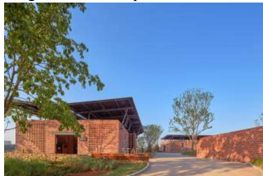
Figura 22 — Rampas de acesso.
