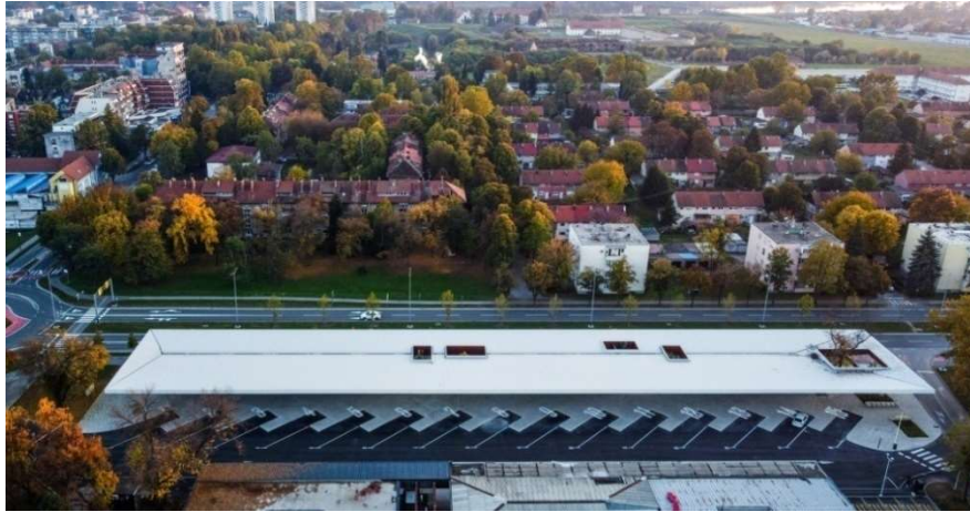
Figura 8 – Vista do Terminal Rodoviário Slavonski Brod.
