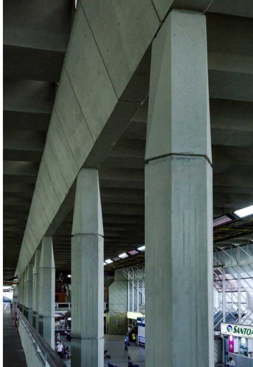
Figura 30 – Estrutura do Terminal Rodoviário Rita Maria.
