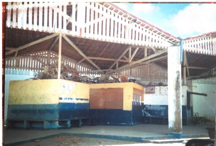
Figura 2 – Antigo terminal Rodoviário de São Miguel, Rio Grande do Norte.
