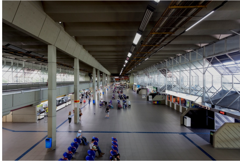
Figura 28 – Circulação destacando a estrutura do Terminal Rodoviário Rita Maria.
