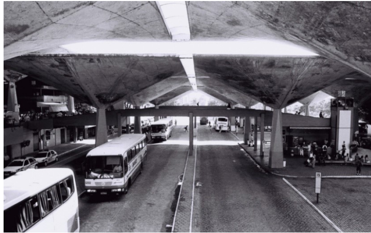
Figura 25 – Pilares do Terminal
