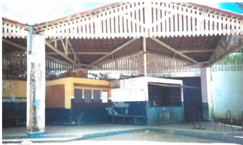
Figura 1 – Antigo terminal Rodoviário de São Miguel, Rio Grande do Norte.
