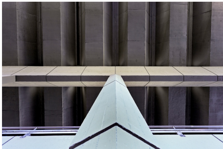
Figura 29 – Estrutura do Terminal Rodoviário Rita Maria.
