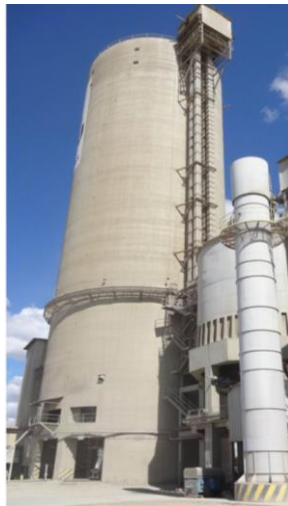
Figura 09 – Silo de armazenamento do cimento.
