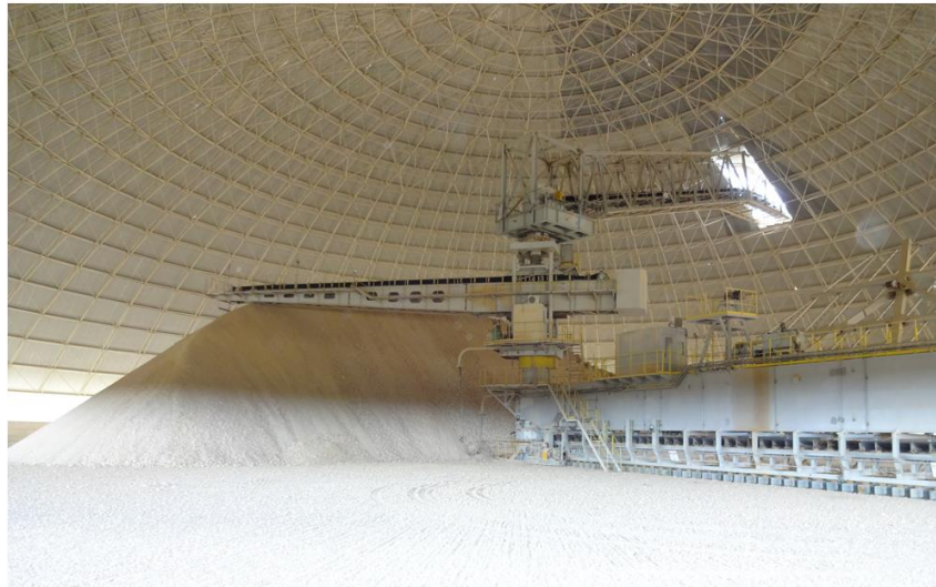
Figura 03 – Formação da pilha de material na parte interna da pré-homogeneização
