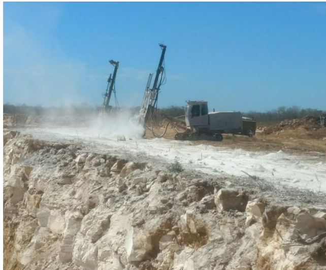
Figura 02 – Perfuração de rocha usando Perfuratrizes
