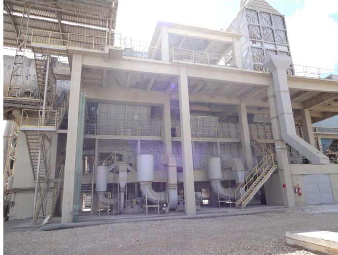
Figura 07 – Resfriador do tipo IKN
