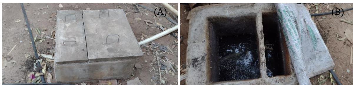
Figura 20. Vista superior da caixa de gordura do sistema bioágua familiar (A) e caixa de gordura destampada (B).
