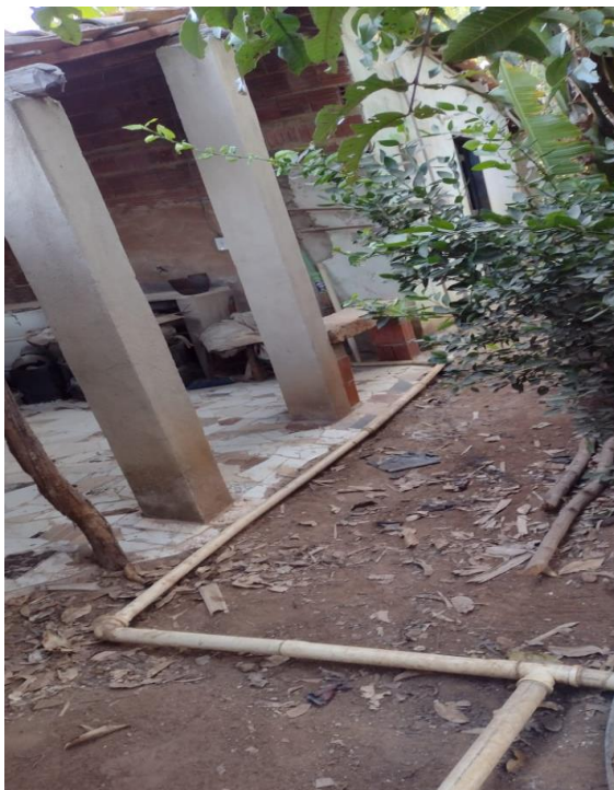
Figura 19. Convergência hidráulica de um sistema bioágua familiar.
