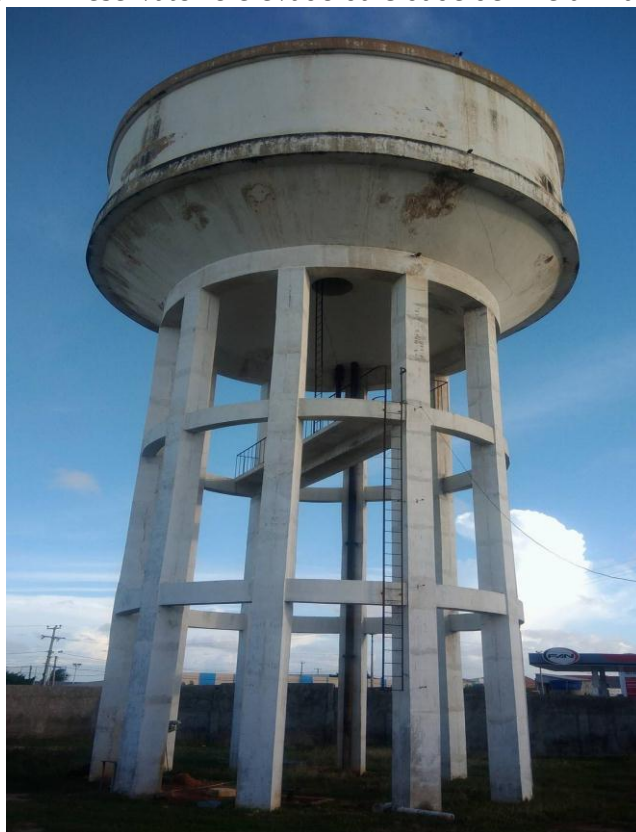
Figura 7 – Reservatório elevado da cidade de Areia Branca/RN
