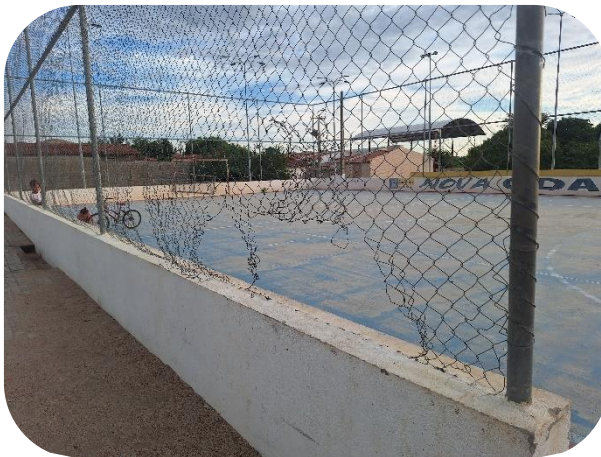
Figura 23 - Praça Antônio Pedro da Costa: Mobiliários Danificados
