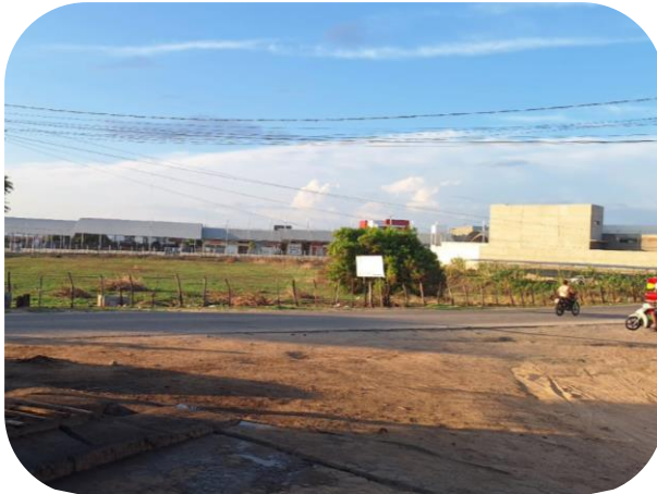
Figura 53 - Fachada Lateral Leste - Av. Pedro Eulâmpio (BR-PB- 293)
