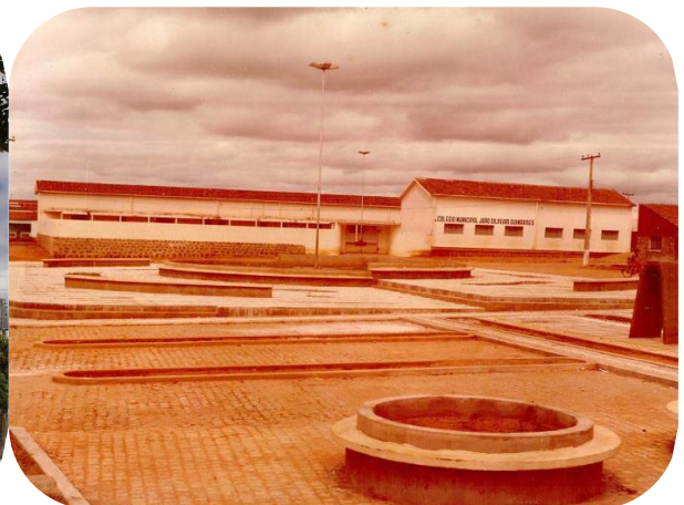
Figura 11 - Construção da Praça da Republica
