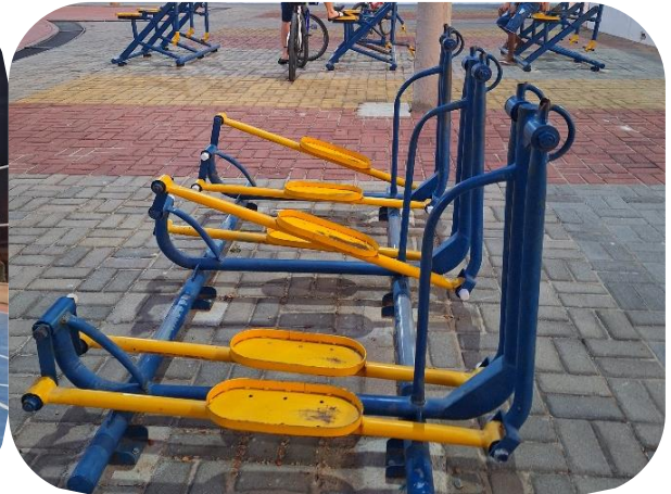
Figura 29 - Complexo Esportivo: Mobiliários Danificados
