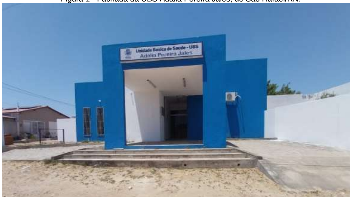
Figura 1 - Fachada da UBS Adália Pereira Jales, de São Rafael/RN.
