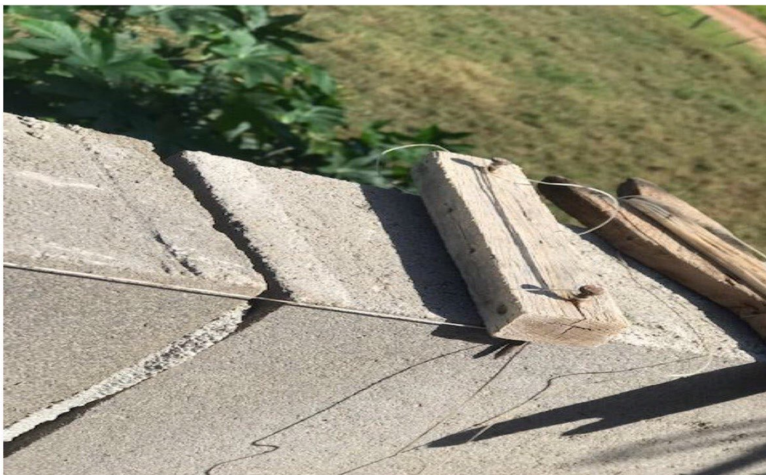
Figura 28 - Apoio de madeira para ancoramento da linha guia
