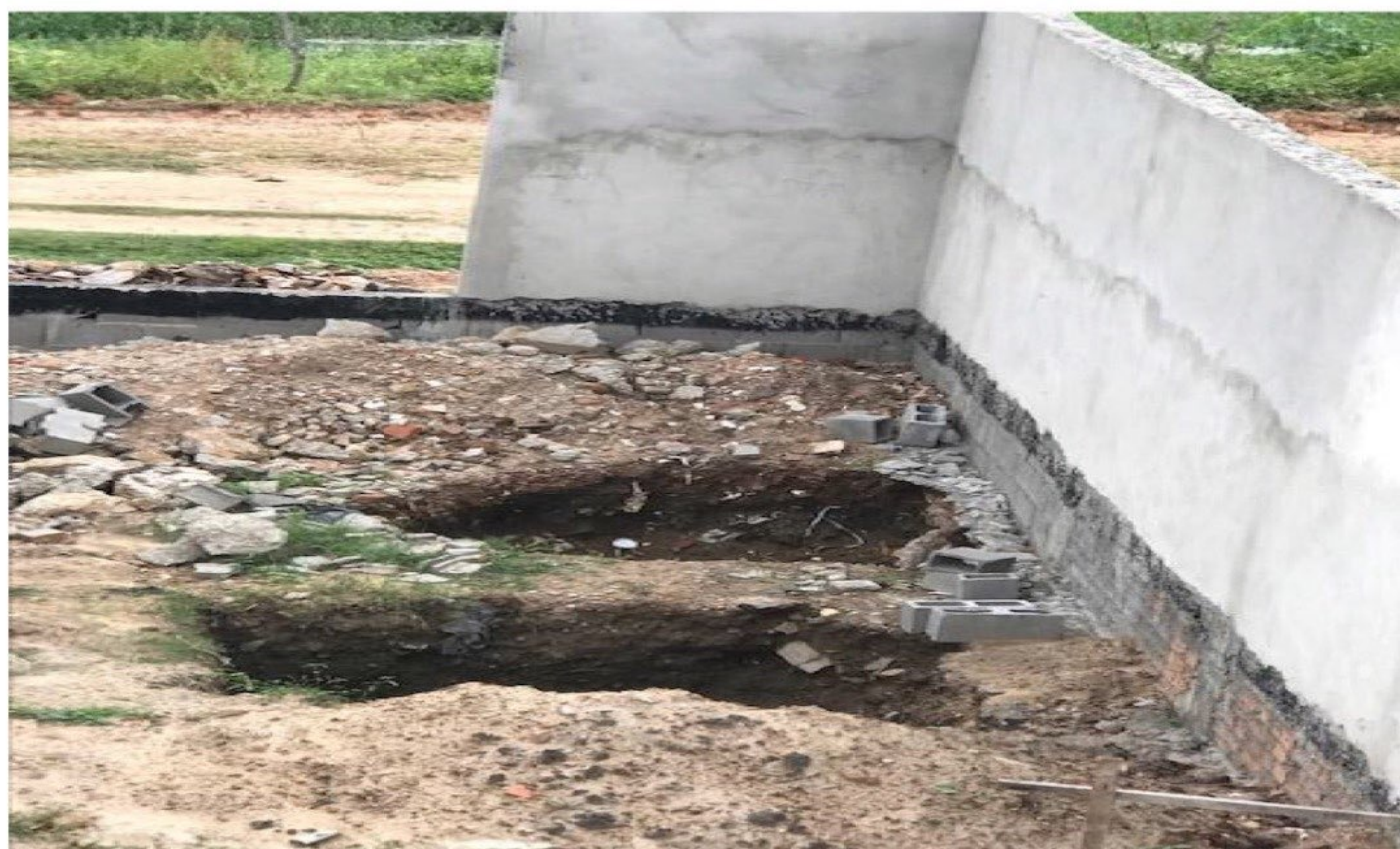
Figura 38 - Valas escavadas do sumidouro e fossa séptica
