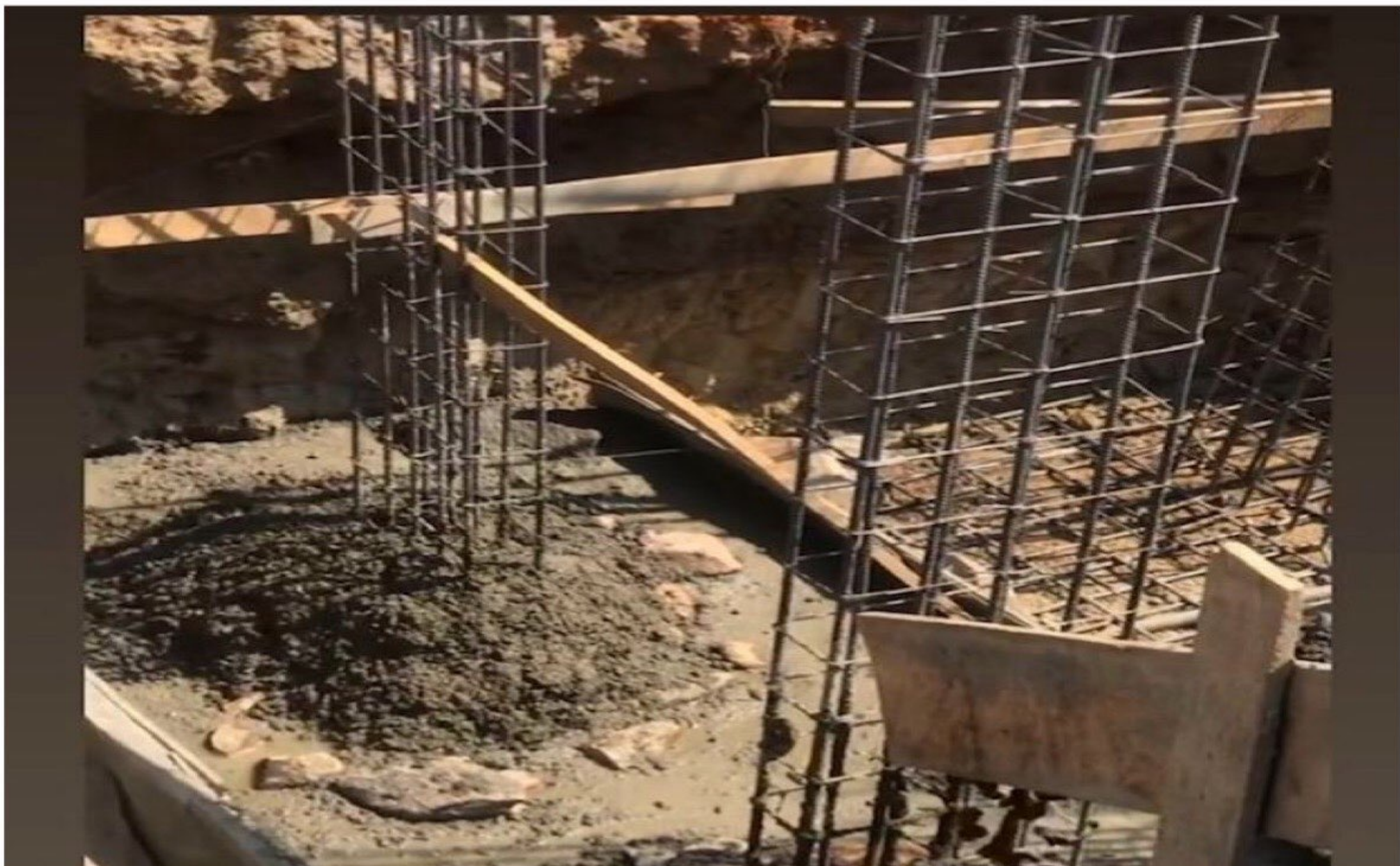
Figura 22 - Concretagem da sapata
