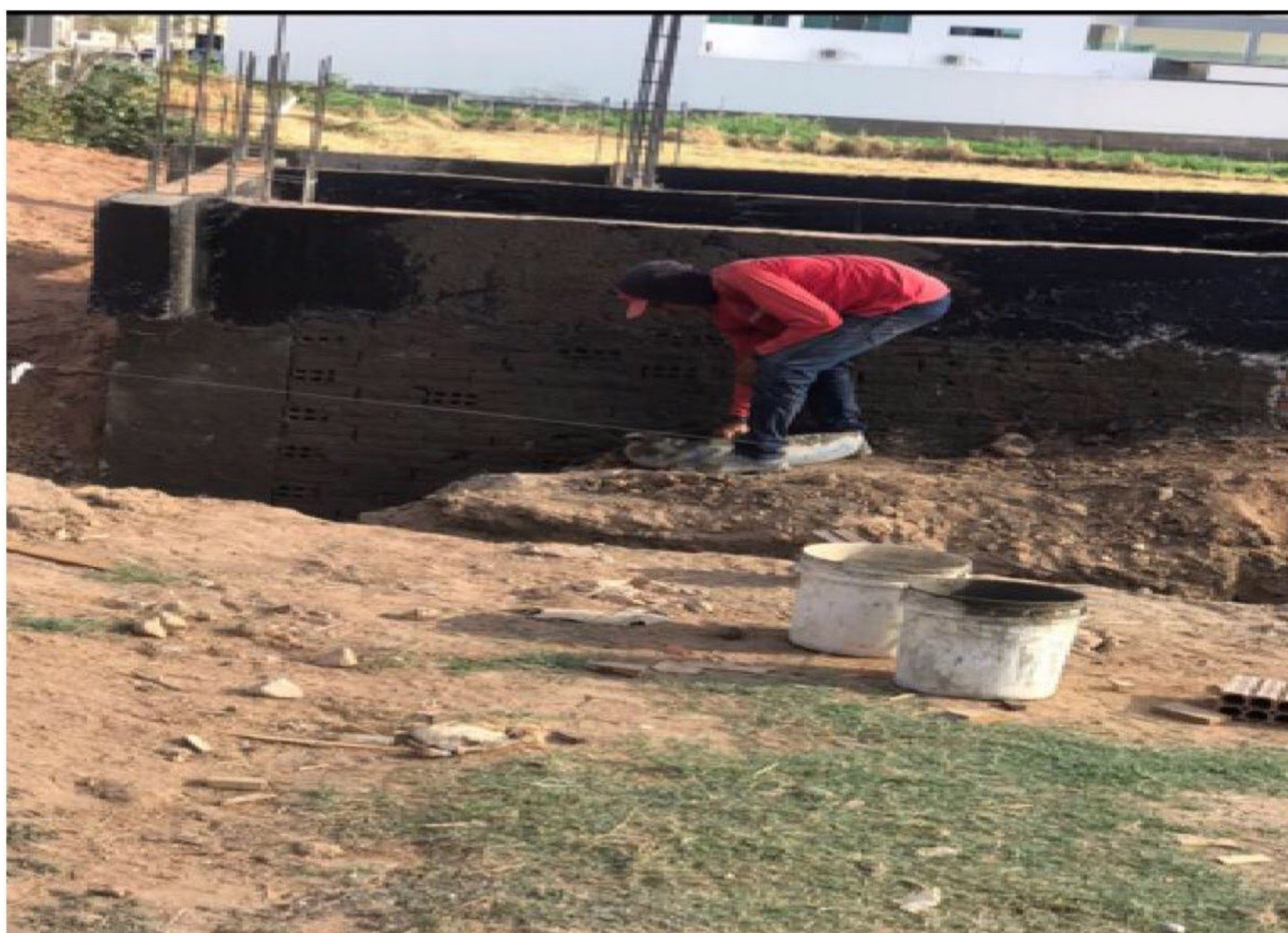
Figura 32 - Impermeabilização do baldrame
