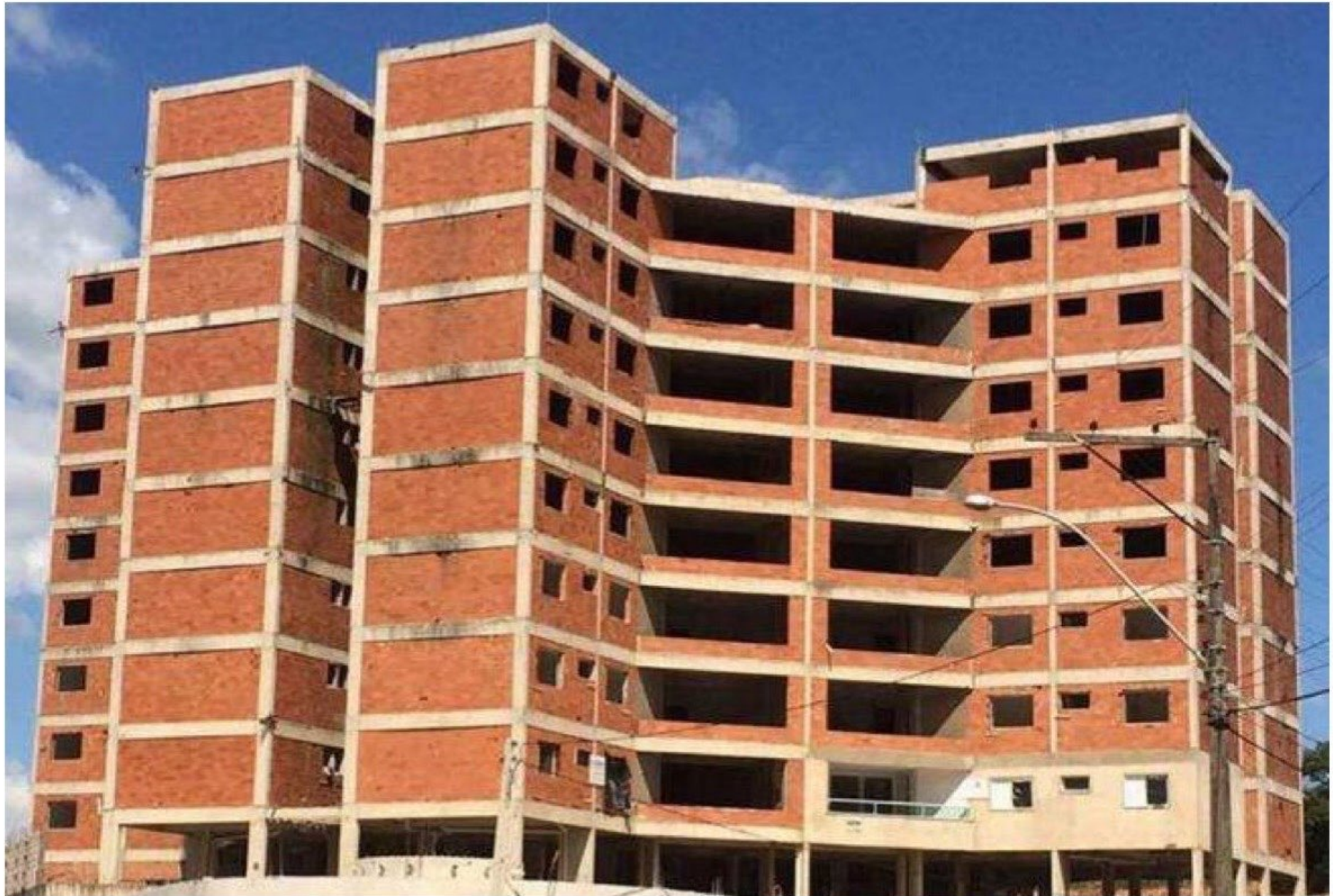
Figura 3 - Edificação em alvenaria convencional
