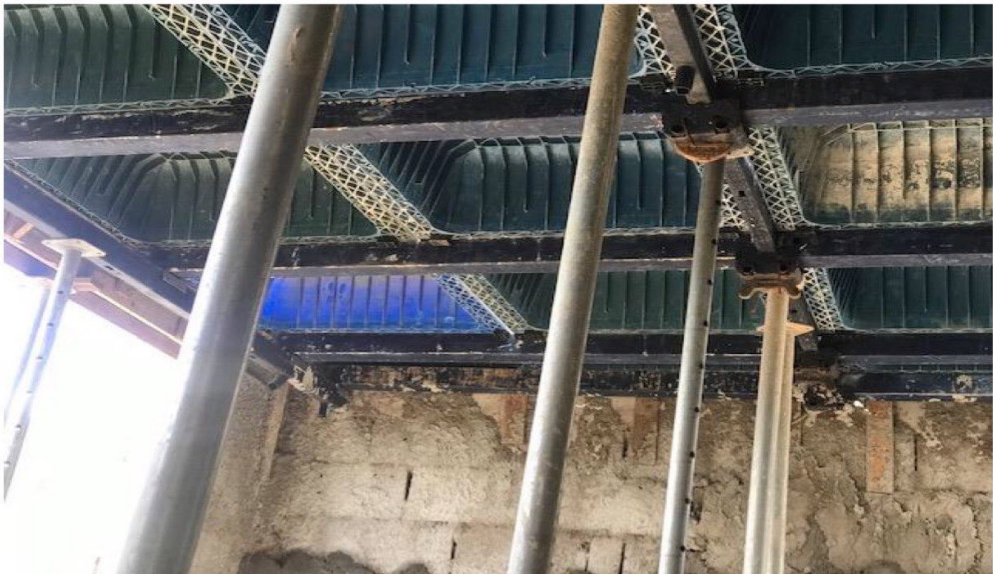
Figura 49 - Montagem do cimbramento metálico
