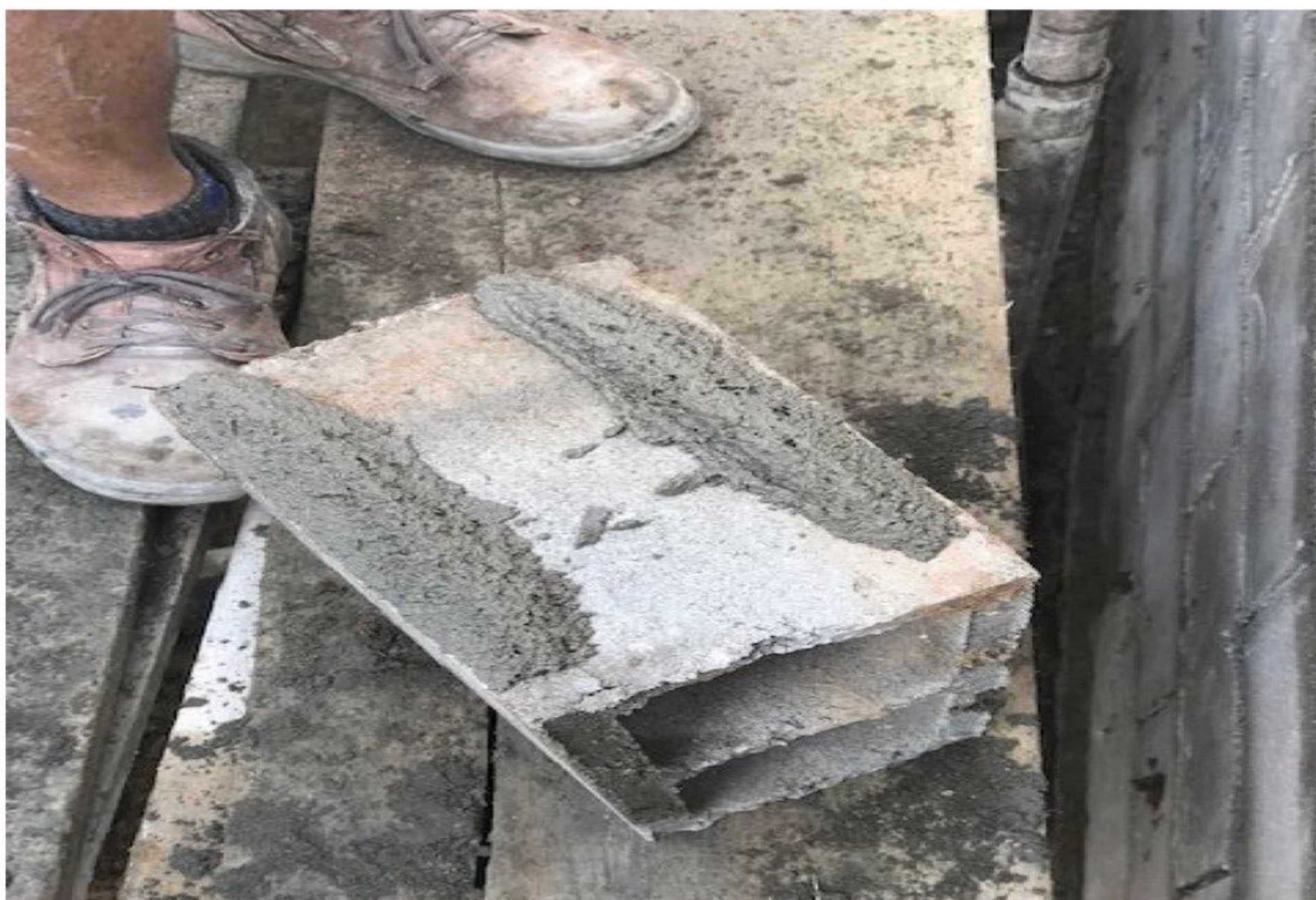
Figura 31 - Argamassa na lateral do bloco
