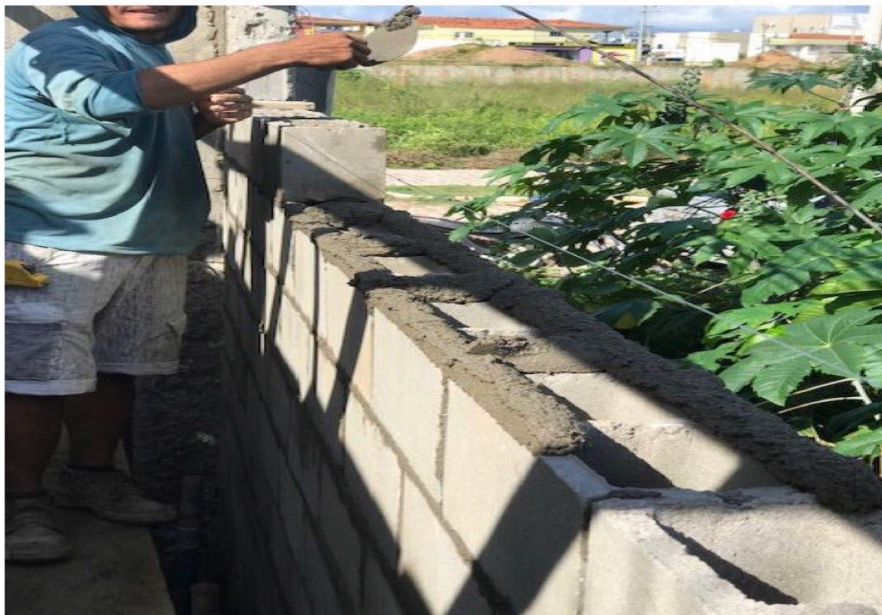
Figura 30 - Assentamento de blocos
