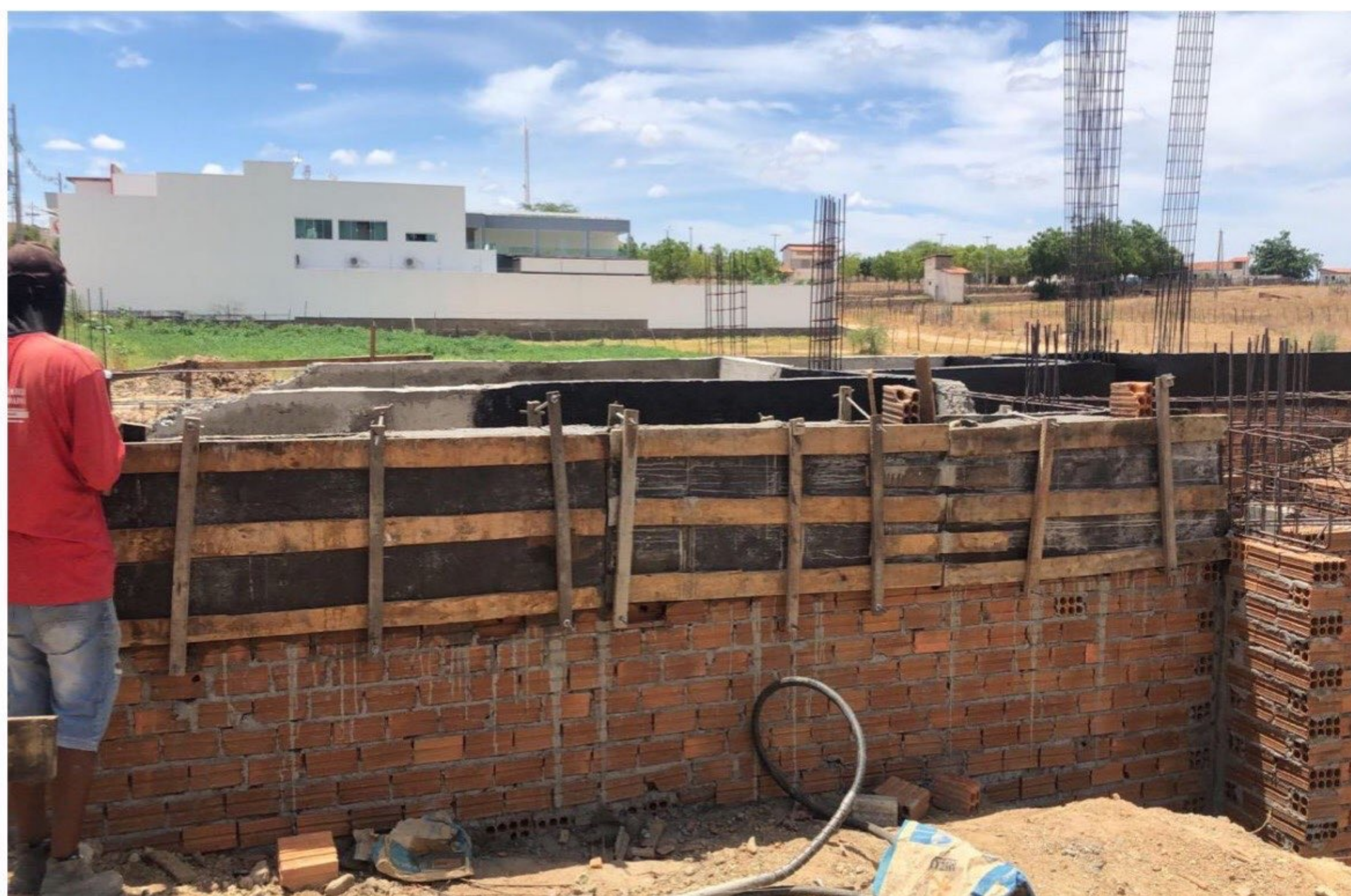
Figura 26 - Caixaria de viga
