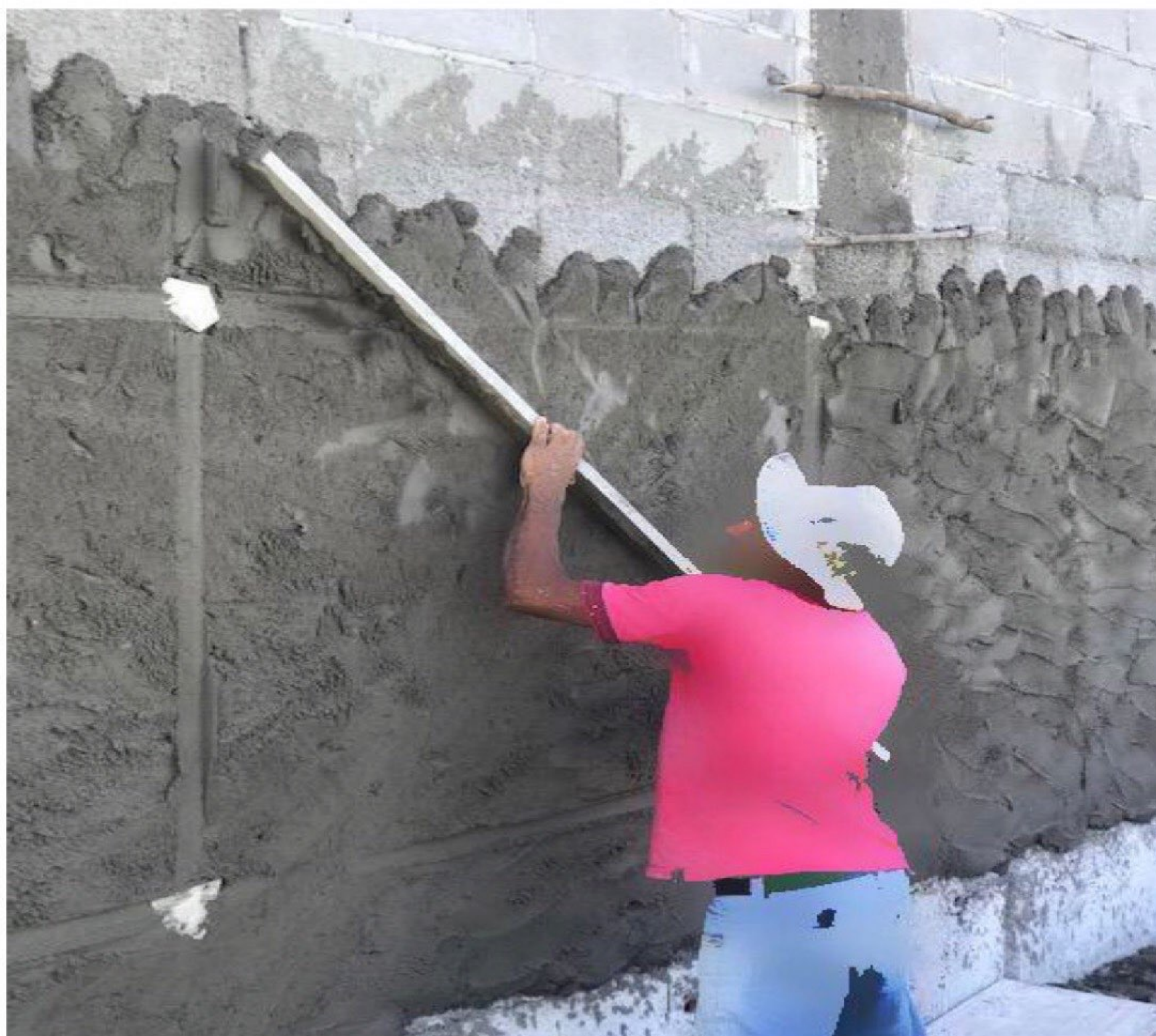
Figura 44 - Execução do reboco
