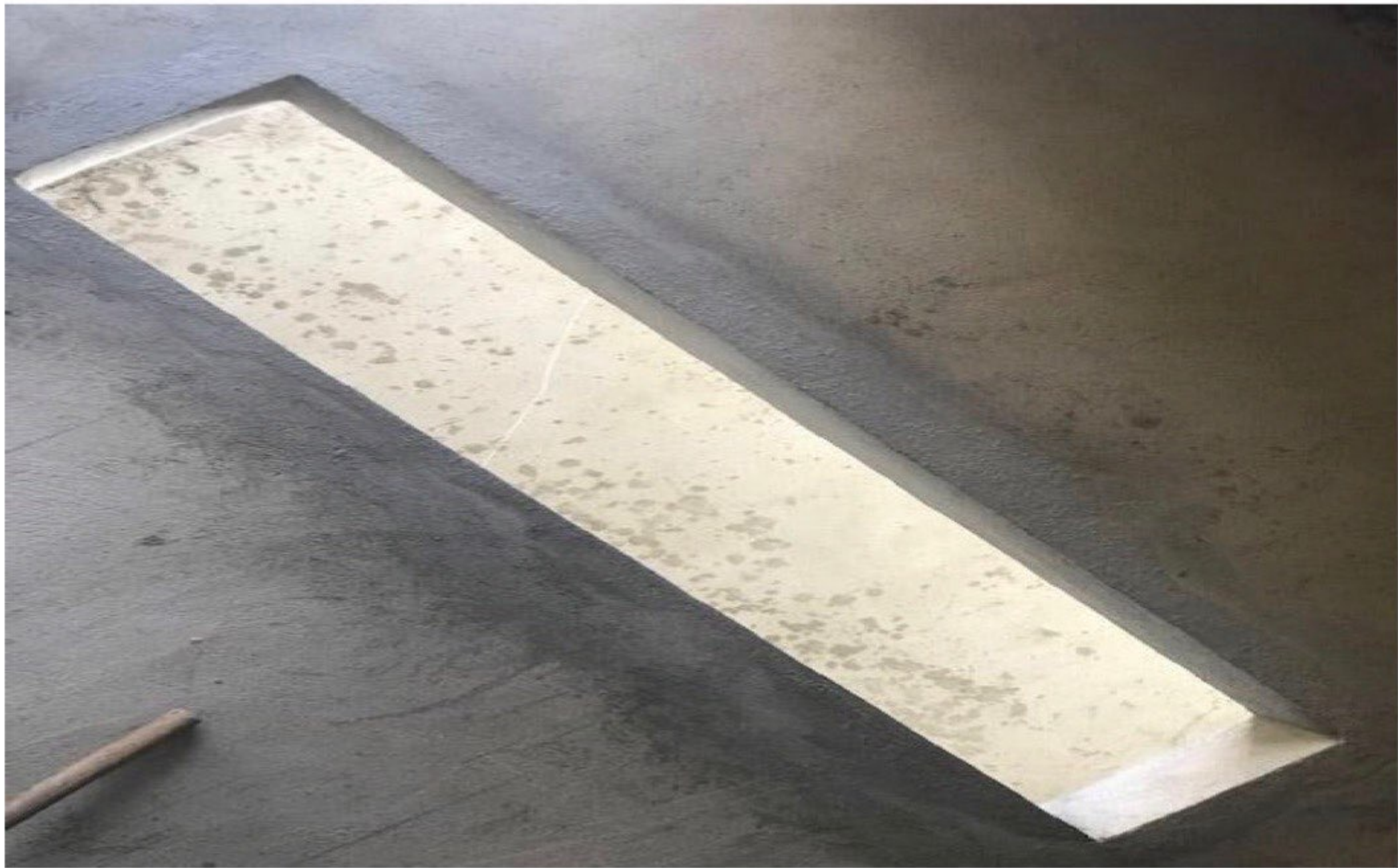
Figura 45 - Janela com vão regularizado
