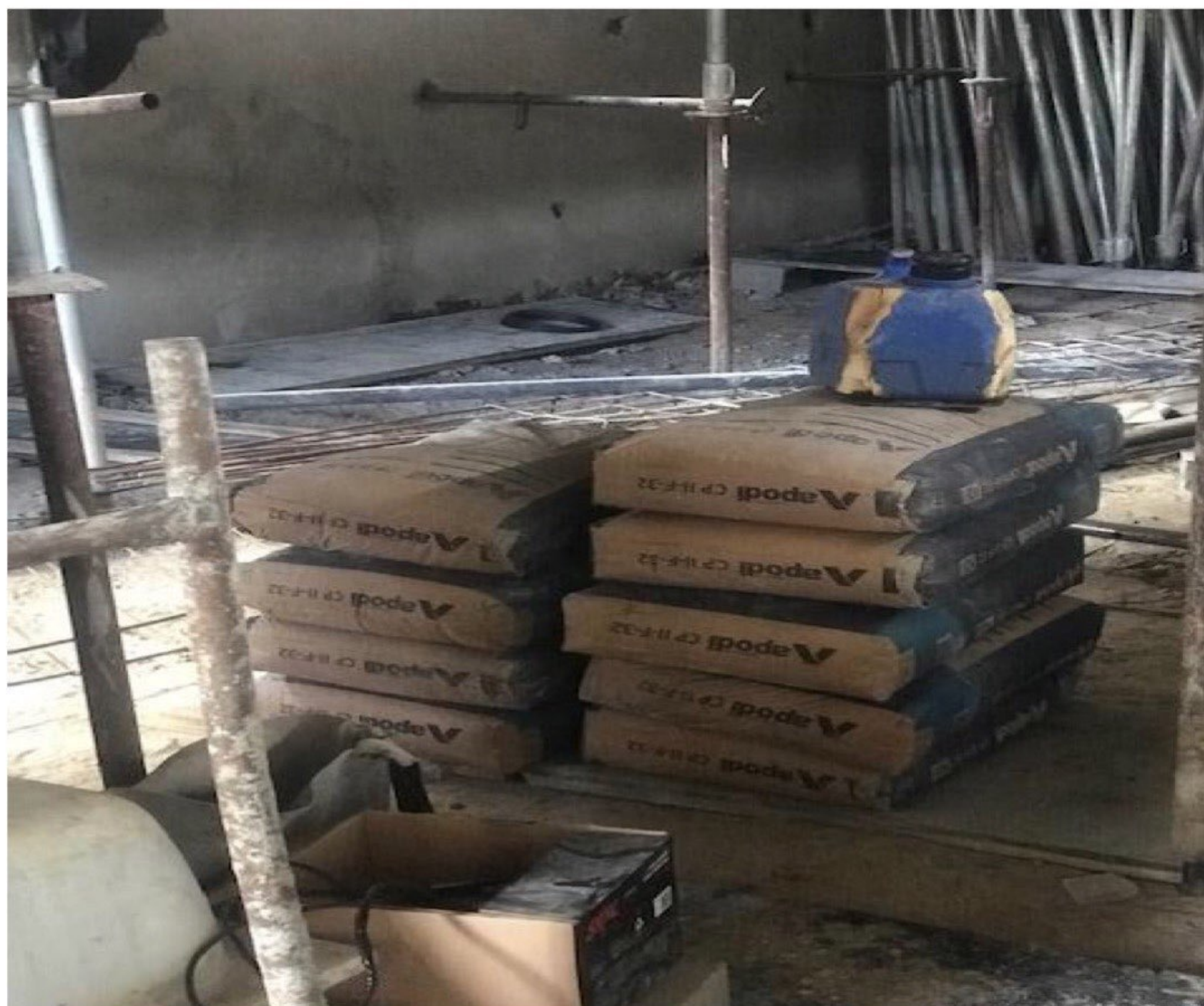
Figura 17 - Local de armazenamento dos sacos de cimento
