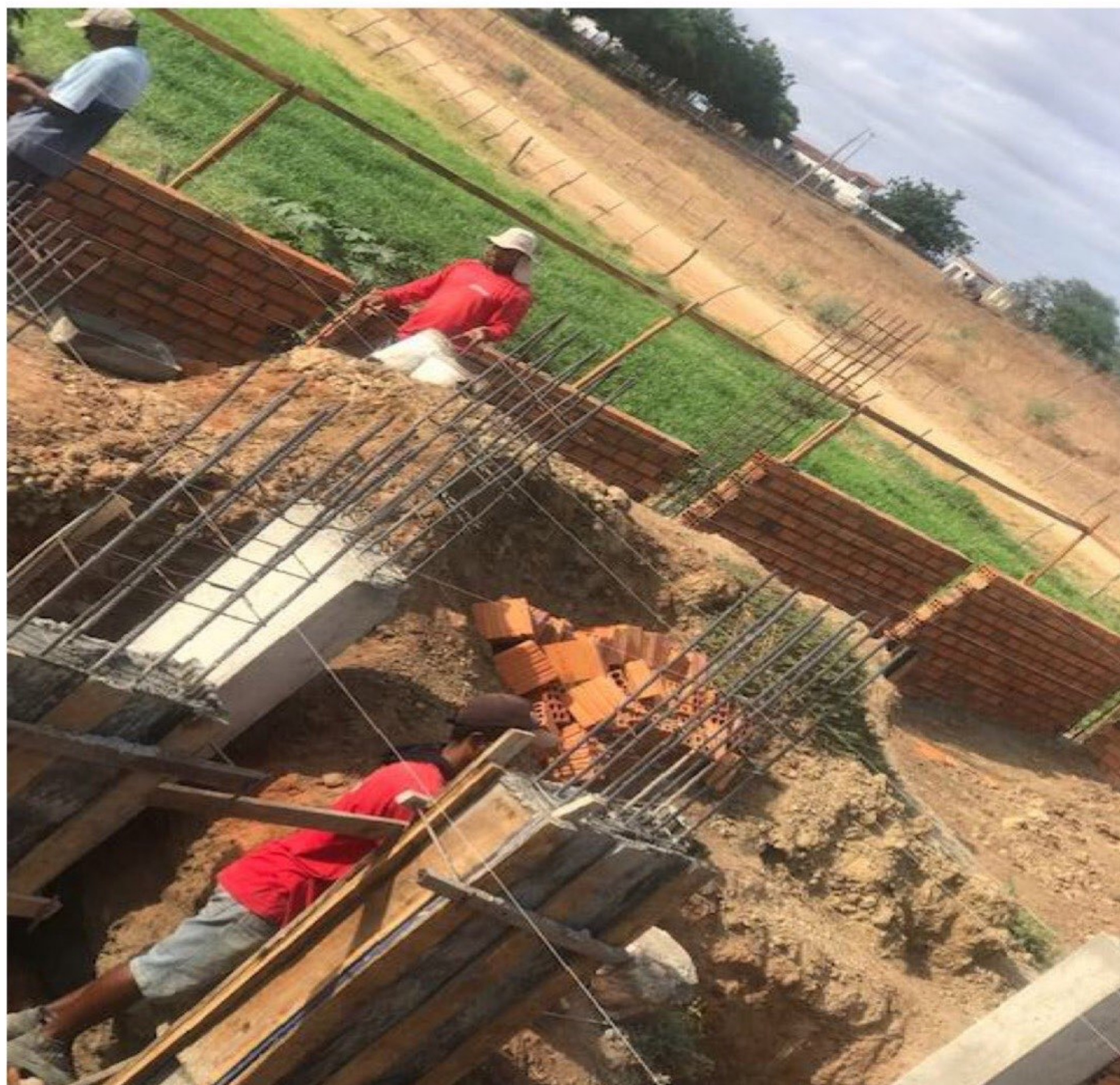
Figura 25 - Armação da caixa de pilar
