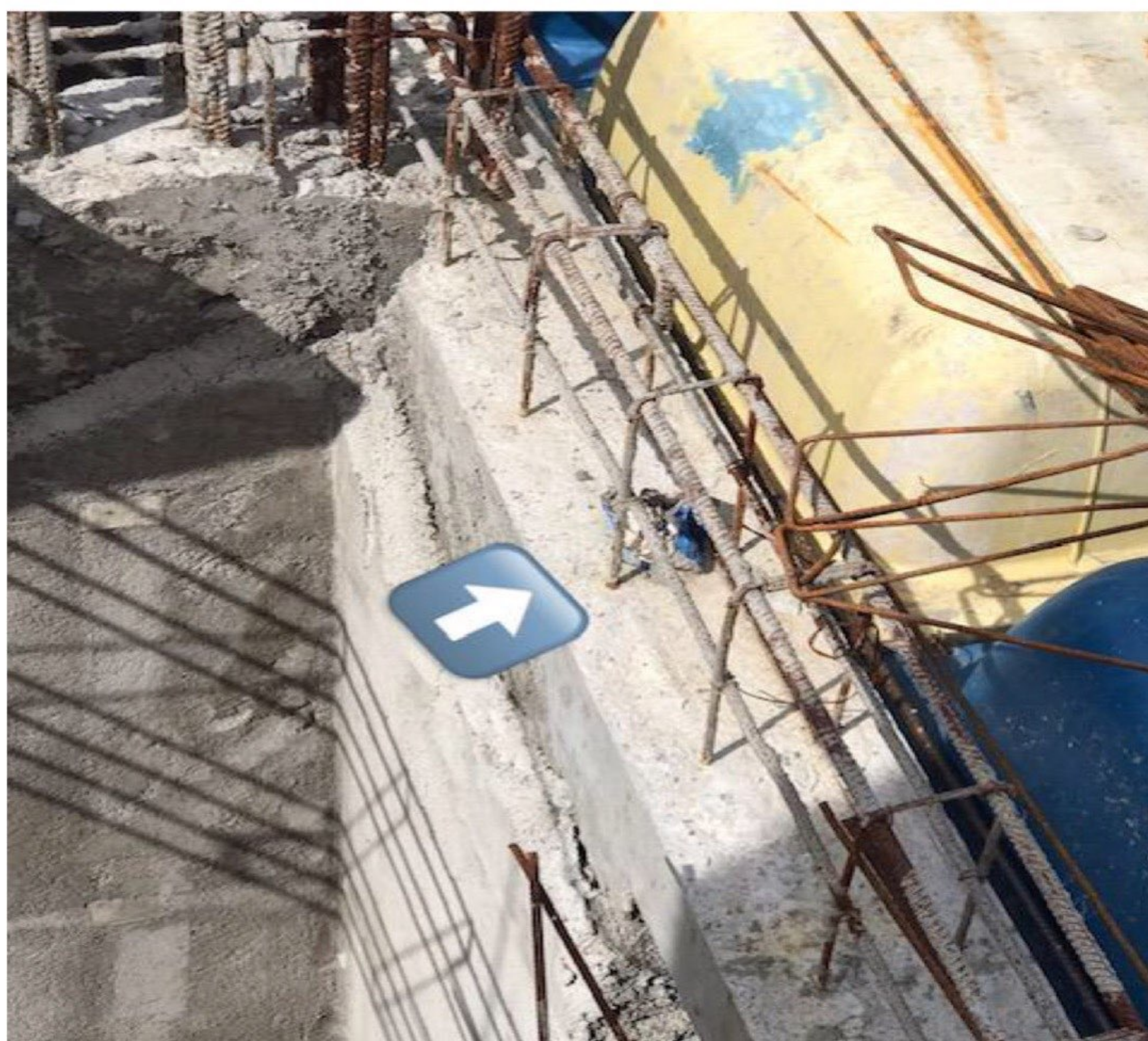
Figura 35 - Furo em viga com papel
