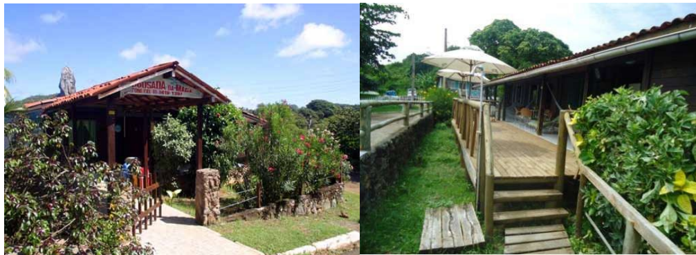
Figura 14: Pousada da Maga fachada (a) frontal e (b) lateral.
