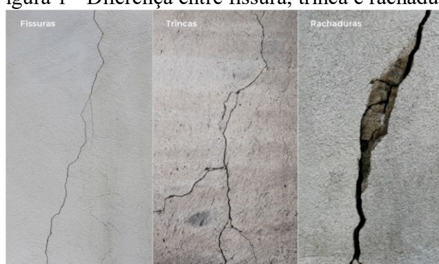
Figura 1 - Diferença entre fissura, trinca e rachadura
