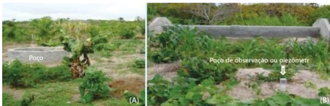
Figura 7 - Poço instalado dentro da área de plantio da barragem subterrânea (A); piezômetro instalado dentro da área de plantio da barragem subterrânea (B).
