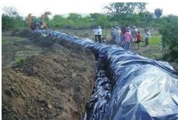
Figura 2 - Abertura de vala para colocação da lona para barramento do fluxo subterrâneo do lençol freático.
