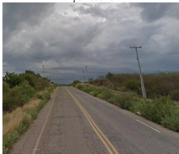
Figura 59 - Rodovia PB-400, Exemplo de Via do Tipo Rodovia
