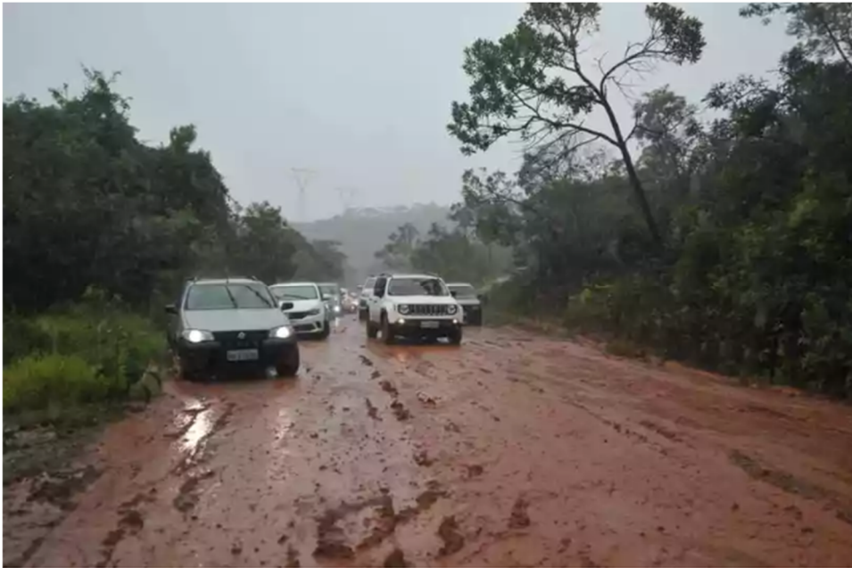
Figura 6 - Congestionamento Devido a Situação Precária da Rodovia
