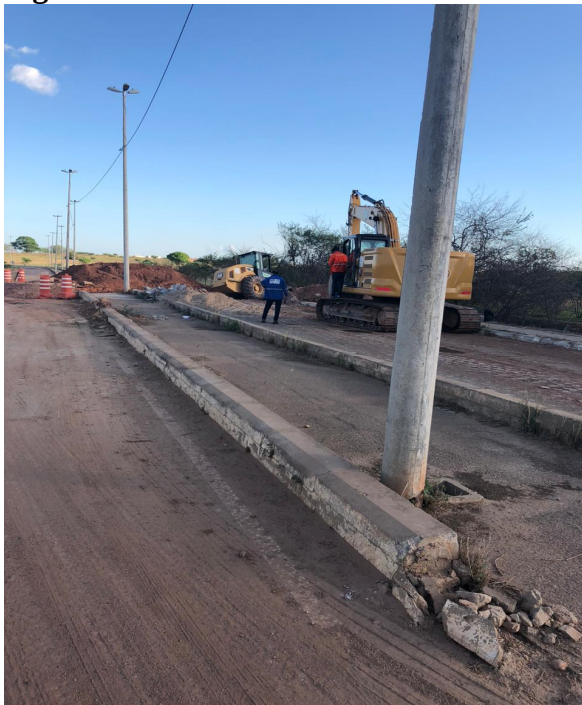
Figura 13 - Trecho em Obra
