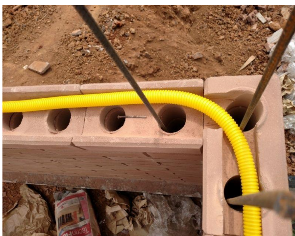
Figura 4: Passagem da fiação nas canaletas.
