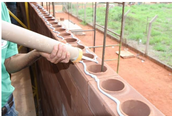
Figura 3: assentamento de tijolos ecológicos com material apropriado:
