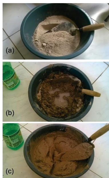
Figura 23: Preparação do cimento para uso.
