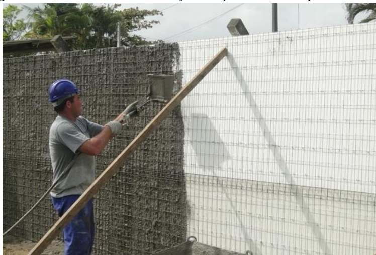
Figura 4.4: Processo de execução de paredes com placas de EPS
