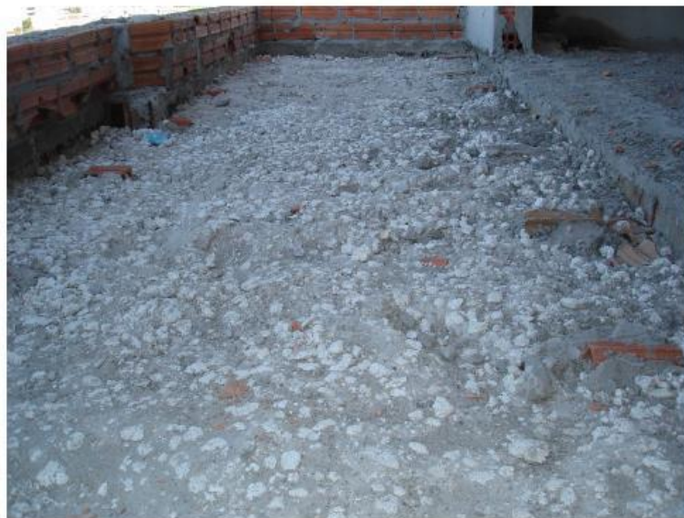
Figura 4.22: Contra piso com aplicação de concreto leve feito com resíduos de EPS.
