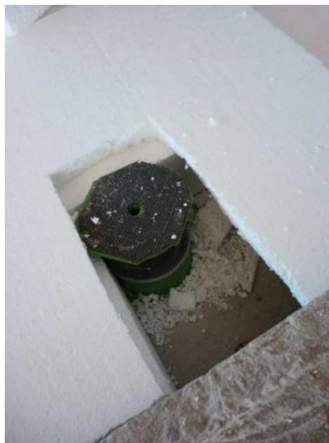
Figura 4.14: Isoamortecedor posicionado no centro da placa de EPS.
