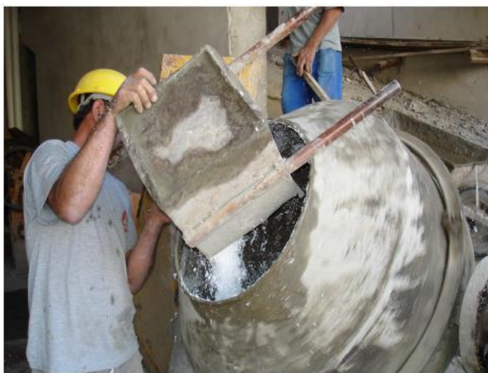
Figura 4.21: Processo preparativo do concreto leve em betoneira.
