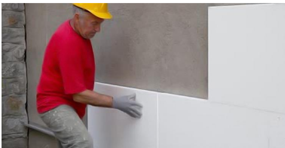
Figura 4.10: Processo de revestimento das placas de EPS.
