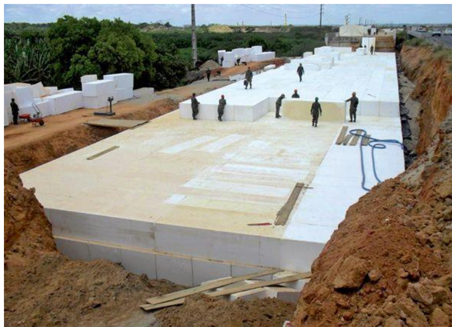
Figura 4.25: Aplicação do EPS em pavimentação.
