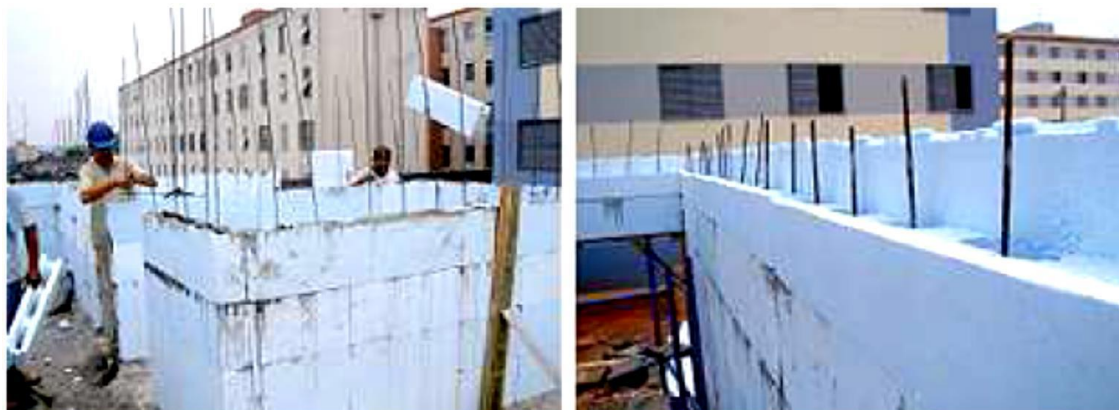
Figura 4.18: Blocos de EPS montados e concretados.
