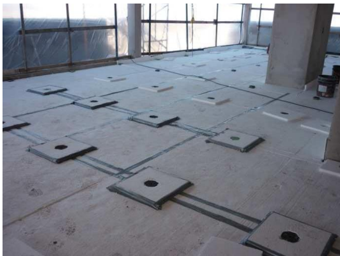
Figura 4.15: Isoamortecedor revestido com placas de EPS.
