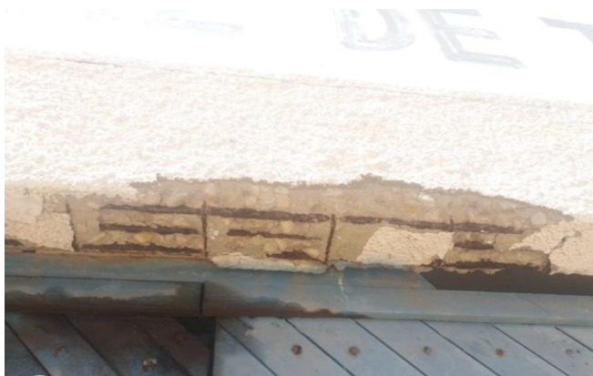
Figura 5 - Armação visível na amostra 3.
