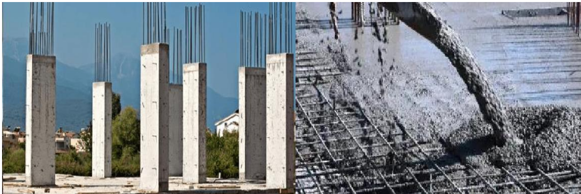
Figura 1 - Representação de concreto armado
