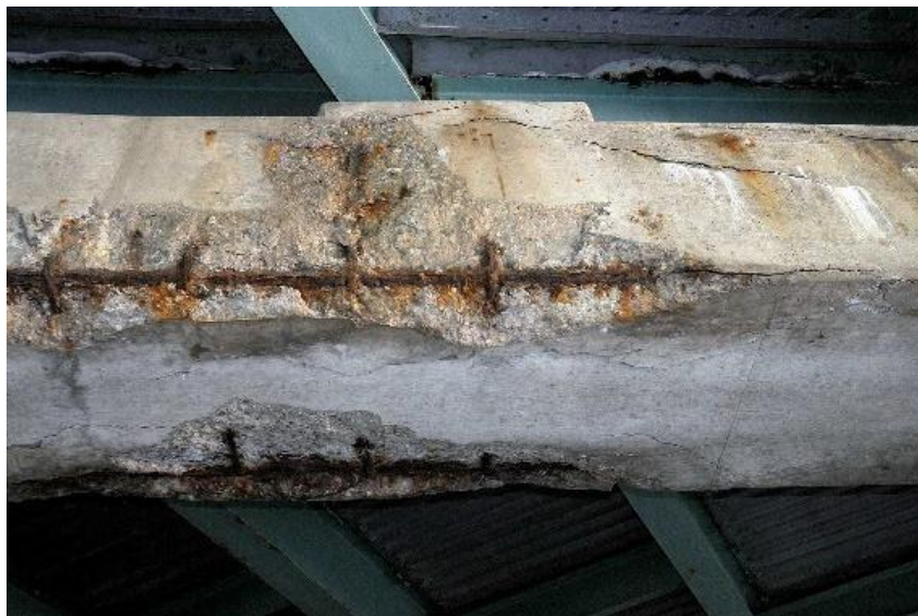
Figura 3 - Representação de corrosão provocada por íons cloreto
