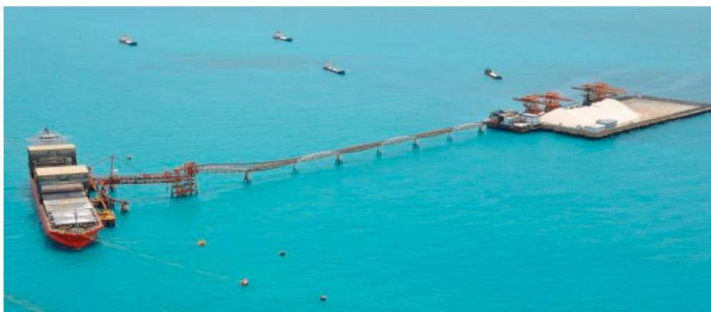
Figura 2: Terminal Salineiro de Areia Branca - TERMISA - Porto Ilha
