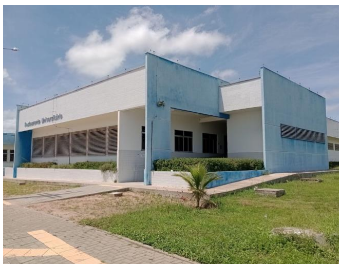
Figura 11 - Restaurante Univerisitário da UFERSA campus Caraúbas
