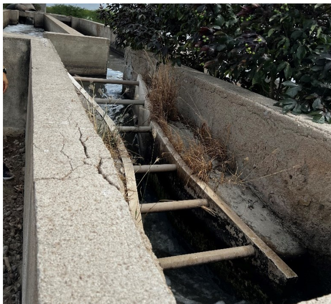
Figura 10 - Medidor de vazão (Calha Parshall ) na Estação de Tratamento de Esgoto Cajazeiras, inserida no município de Mossoró-RN
