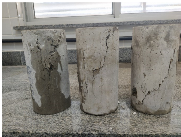
Figura 30 – Resultado do ensaio de compressão axial (concreto convencional)
