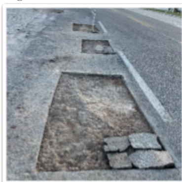
Figura 4: corte ao redor da área degradada
