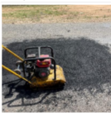
Figura 7 - Compactação com uso do Soquete vibratório.
