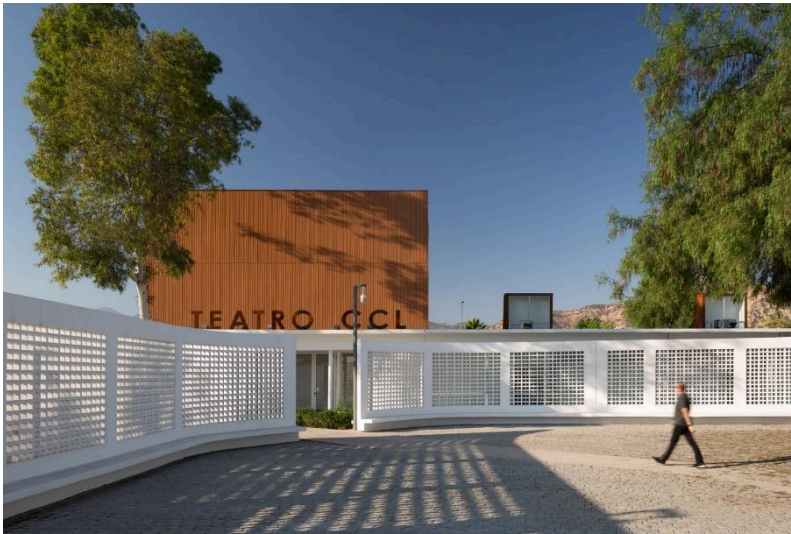
Figura 15– Vista interna Centro Cultural Lampa
