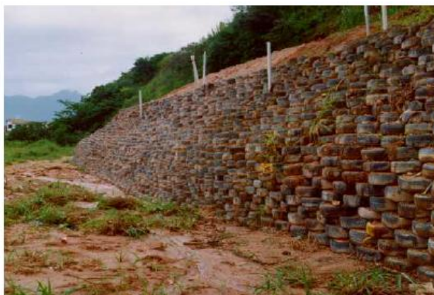
Figura 11 – Resultado da construção do muro
