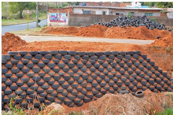
Figura 12 – Proteção de Taludes
