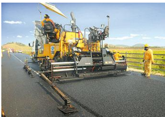
Figura 9 – Aplicação do asfalto modificado por borracha (AMB)
