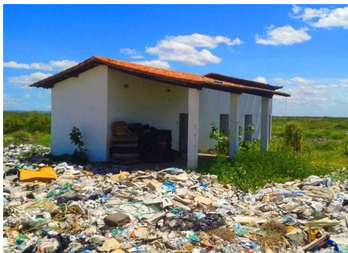
Figura 25 – Situação do galpão na segunda visita ao local
