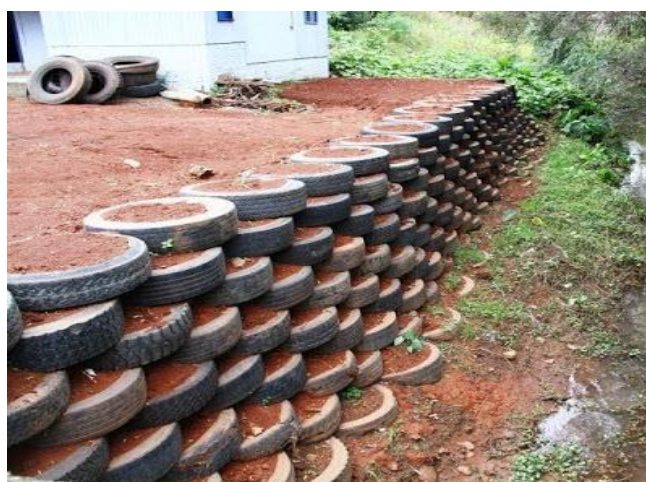
Figura 13 – Controle de erosão
