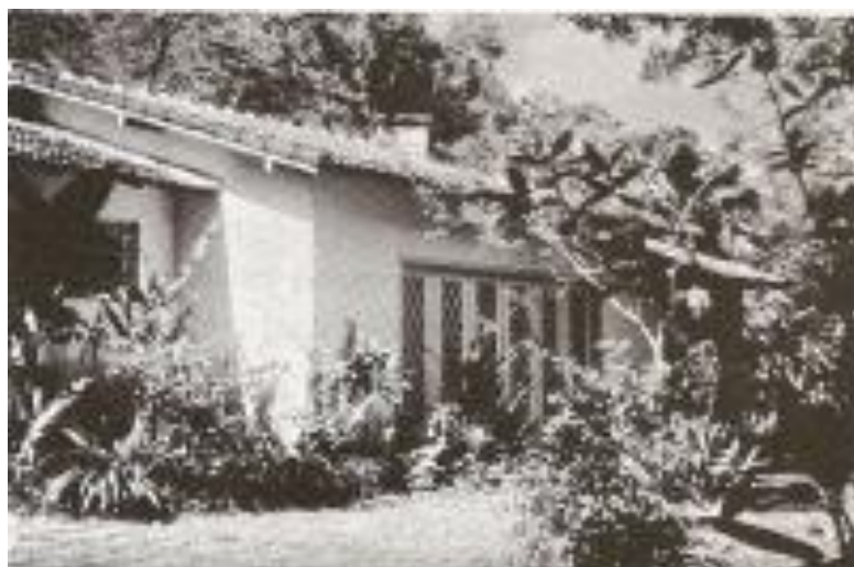
Figura 1- Residencial com paredes monolíticas de solo-cimento em Petrópolis
