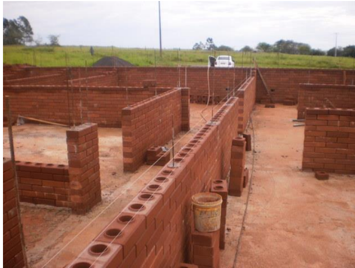
Figura 16- Canteiro de obra organizado
