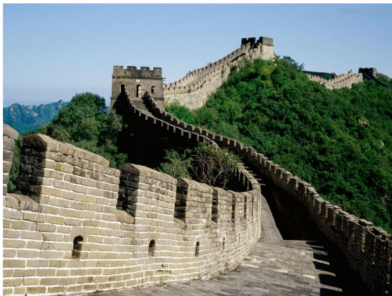
Figura 4 - Muralha da China
