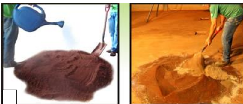
Figura 8 - Preparação da mistura – adição de água na mistura.
