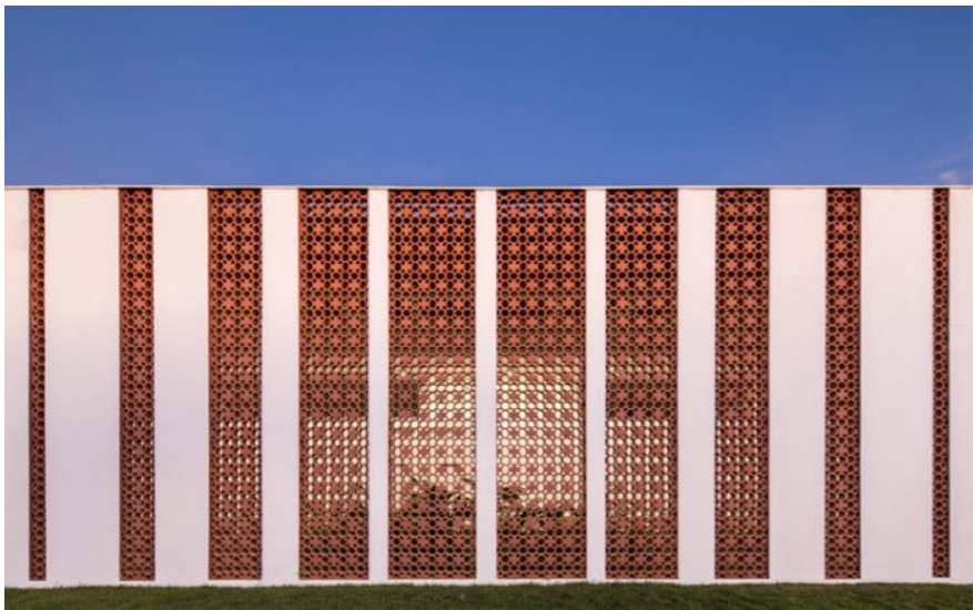
Figura 19: Fachada com a presença de cobogós cerâmicos
