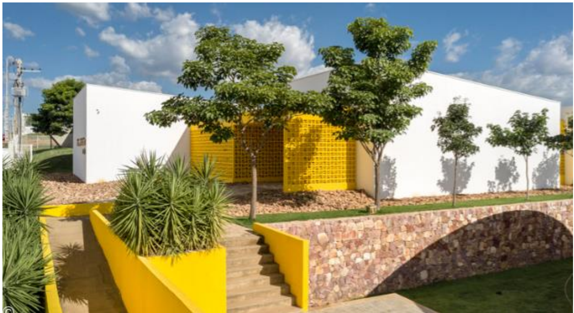
Figura 10: Fachada frontal Núcleo de Prática Jurídica Unileão
