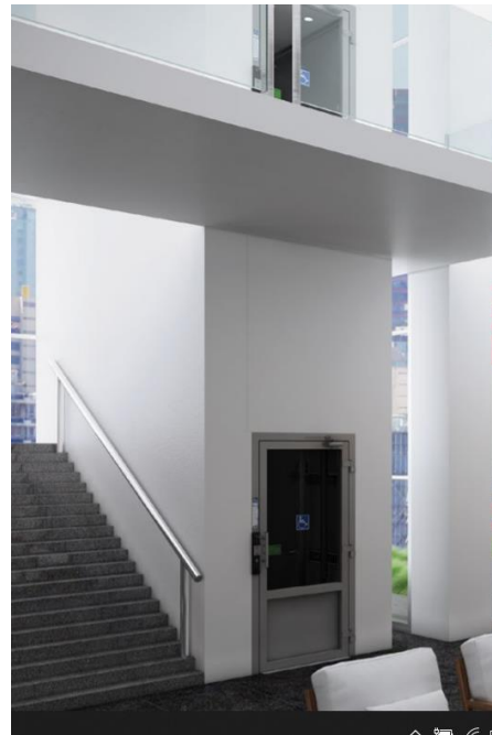
Figura 72: Plataforma elevatória cravada na alvenaria
