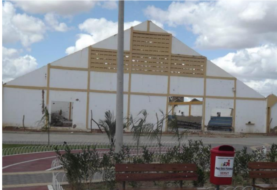
Figura 30: Antigo Ginásio Professor João Faustino em demolição no ano de 2012
