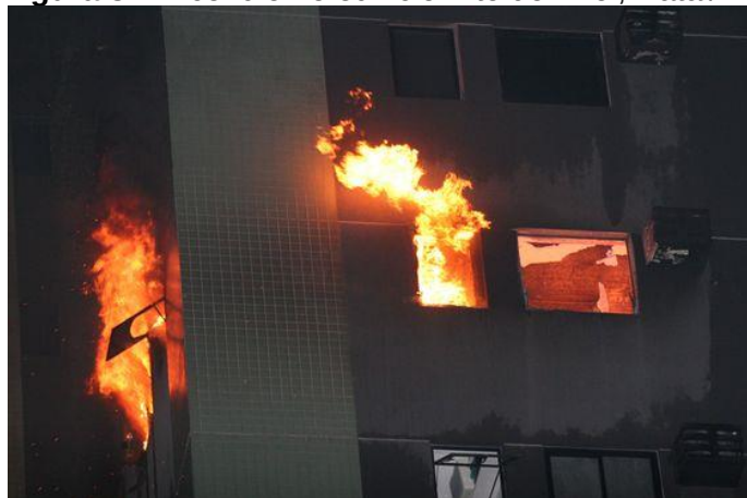
Figura 3 – Incêndio no edifício Alto do Tirol, Natal/RN
