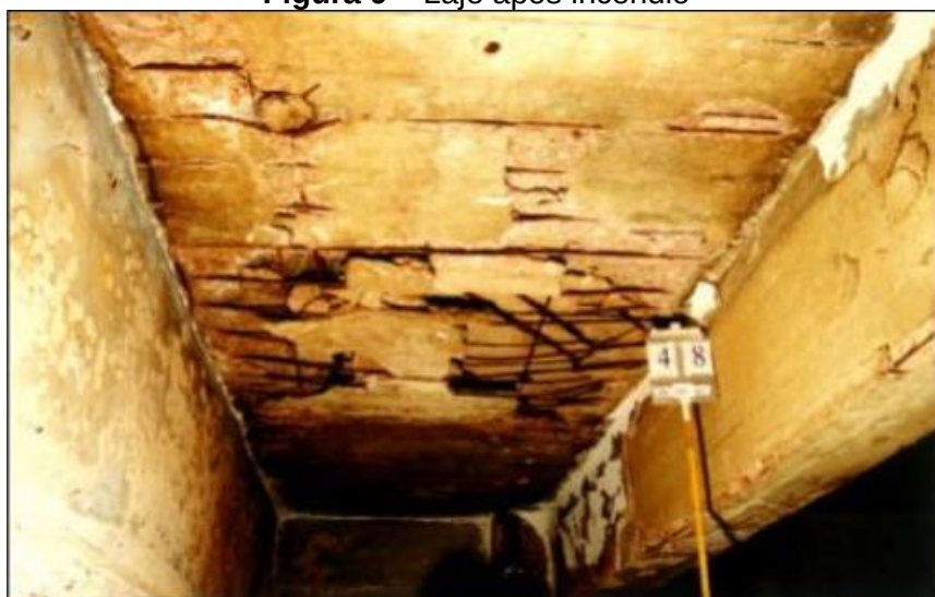
Figura 9 – Laje após incêndio
