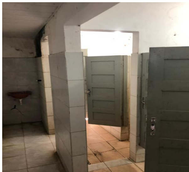
Figura 13: Banheiro dos operários
