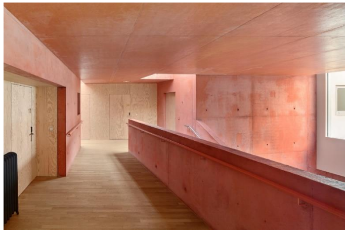
Figura 14 – Utilização do concreto vermelho.
