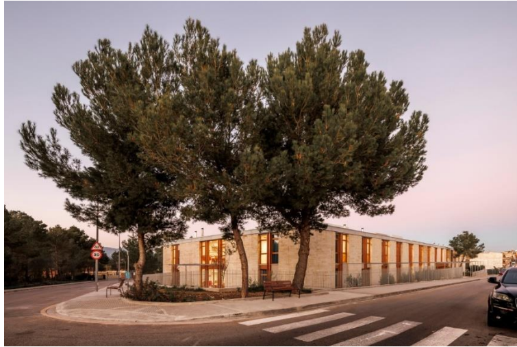
Figura 31 – Acesso para a edificação.
