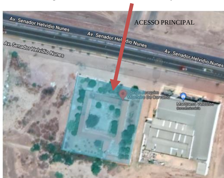
Figura 40 – Acesso externo da edificação.
