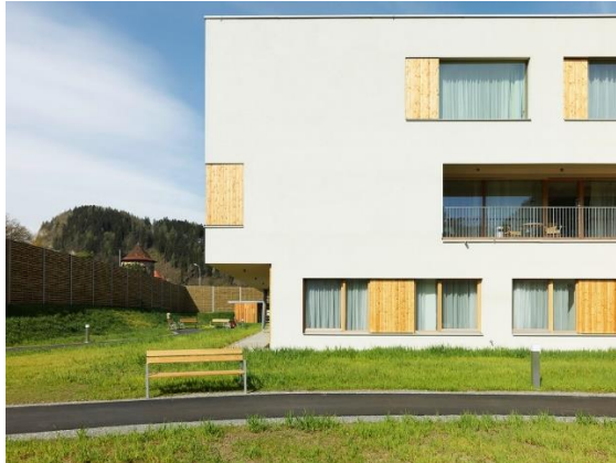
Figura 25 – Volumetria fachada e cafeteria.
