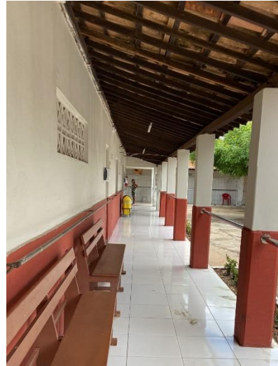
Figura 46 – Corredores de circulação.
