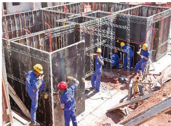
Figura 3 – Utilização de guarda-corpos junto aos painéis de fôrmas.
