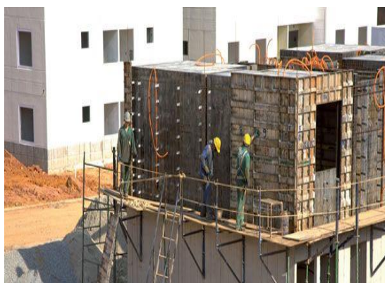
Figura 3 – Utilização de guarda-corpos junto aos painéis de fôrmas.
