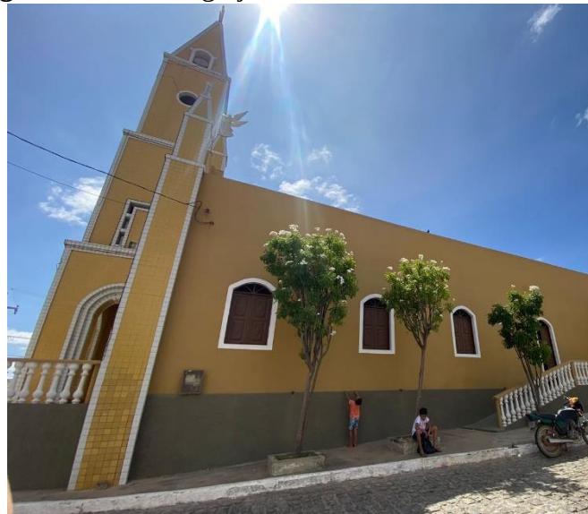
Figura 17 – Atual Igreja da Cidade – Fachada lateral
